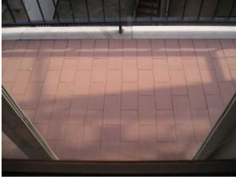
Foto n. 18: particolare balcone - immobile 2
