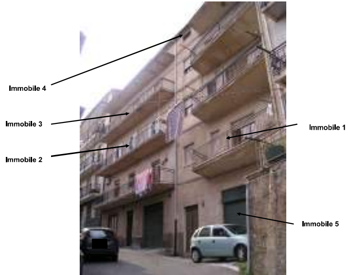
Foto n. 1: fabbricato di cui fanno parte gli immobili pignorati
