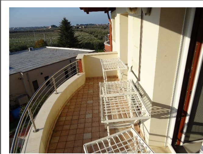
Piano 2°: Balcone locali 2 e 3
