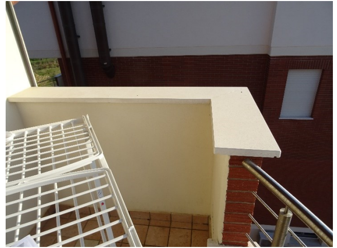
Piano 2°: Balcone locali 2 e 3
