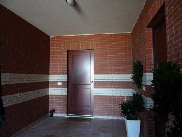
Ballatoio Primo Piano e ingresso all'appartamento
