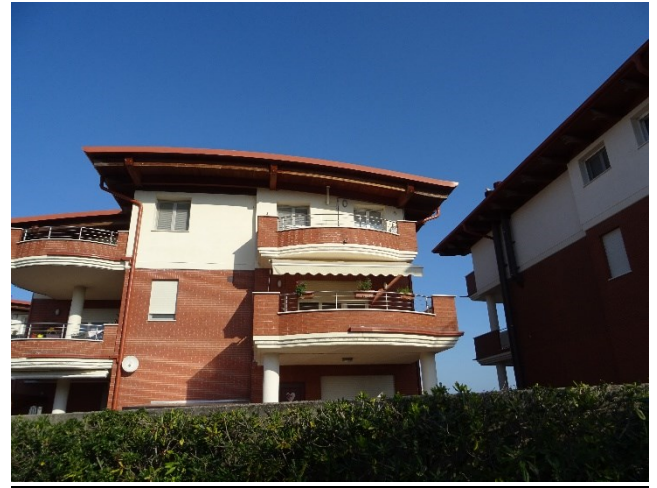
Vista Esterna da Lato N-O : Piani 1-2
