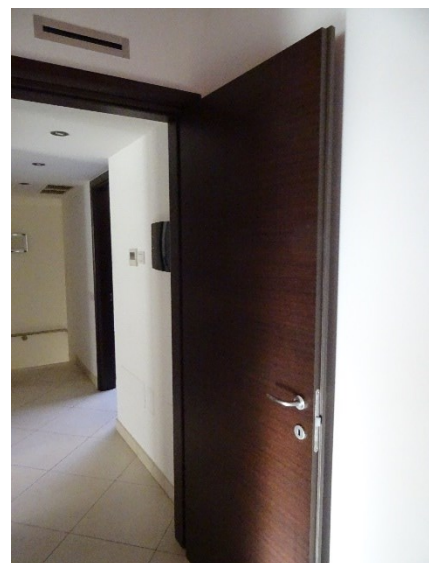
Particolare porte interne
