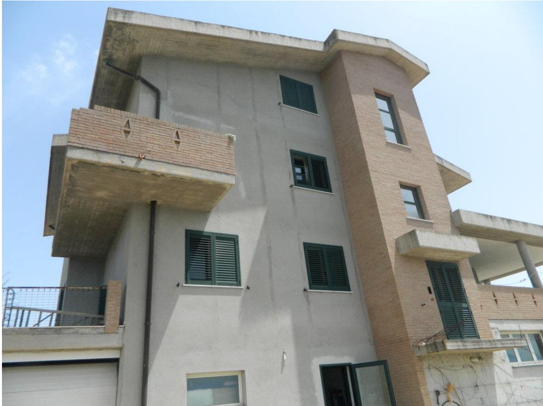
Foto 03 – Vista esterna immobile
