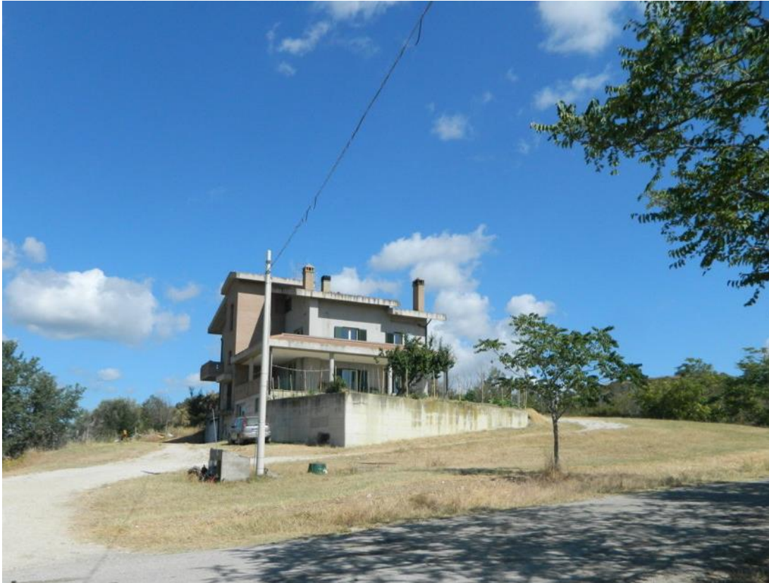
Foto 01 – Vista esterna immobile
