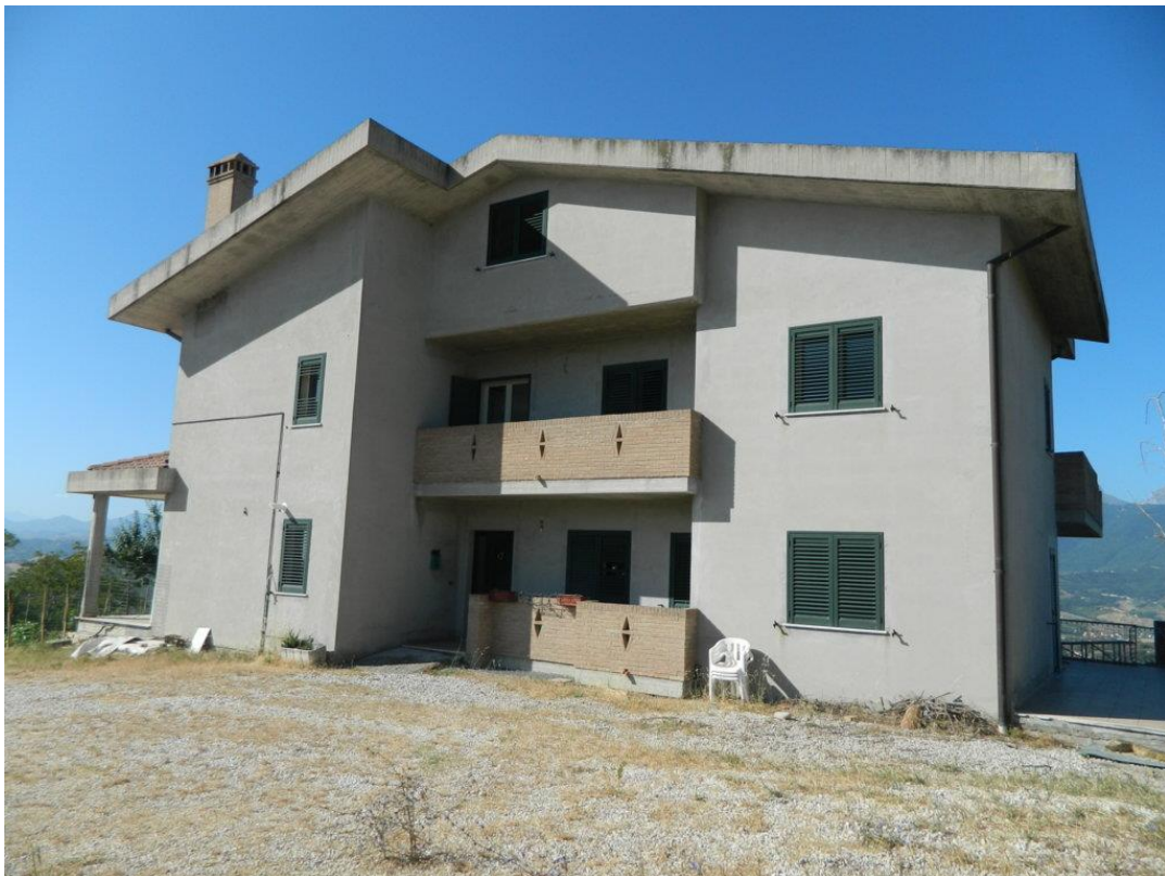
Foto 02 – Vista esterna immobile
