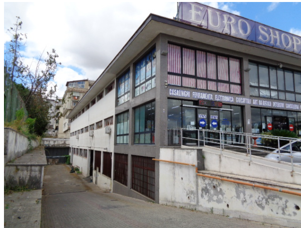
Prospetto lato est: rampa d'accesso al garage al PS1
