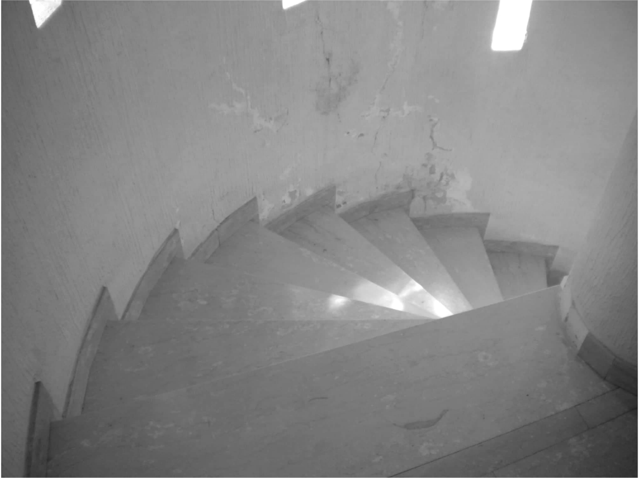
scala interna accesso pianerottolo
