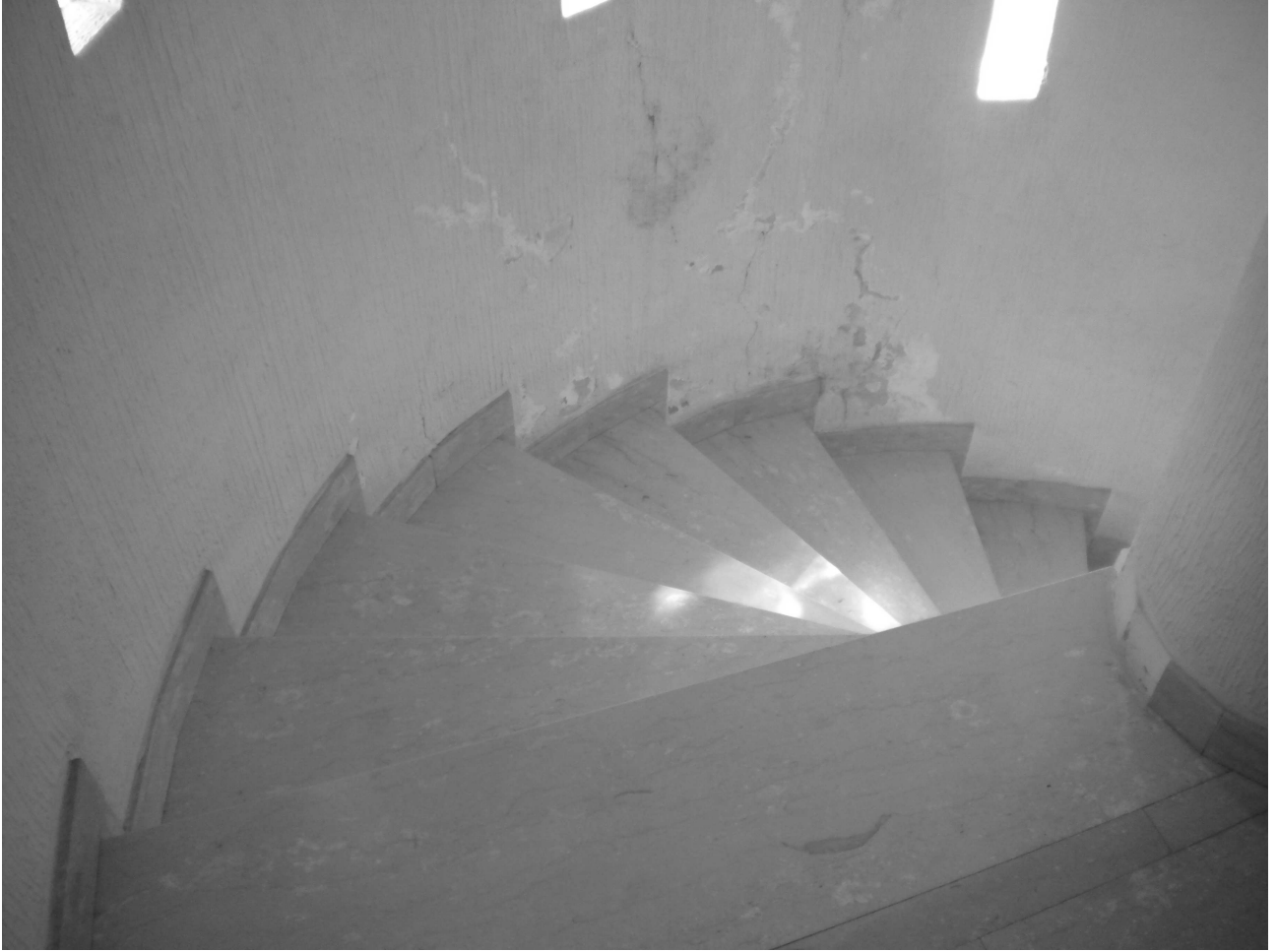
scala interna accesso pianerottolo
