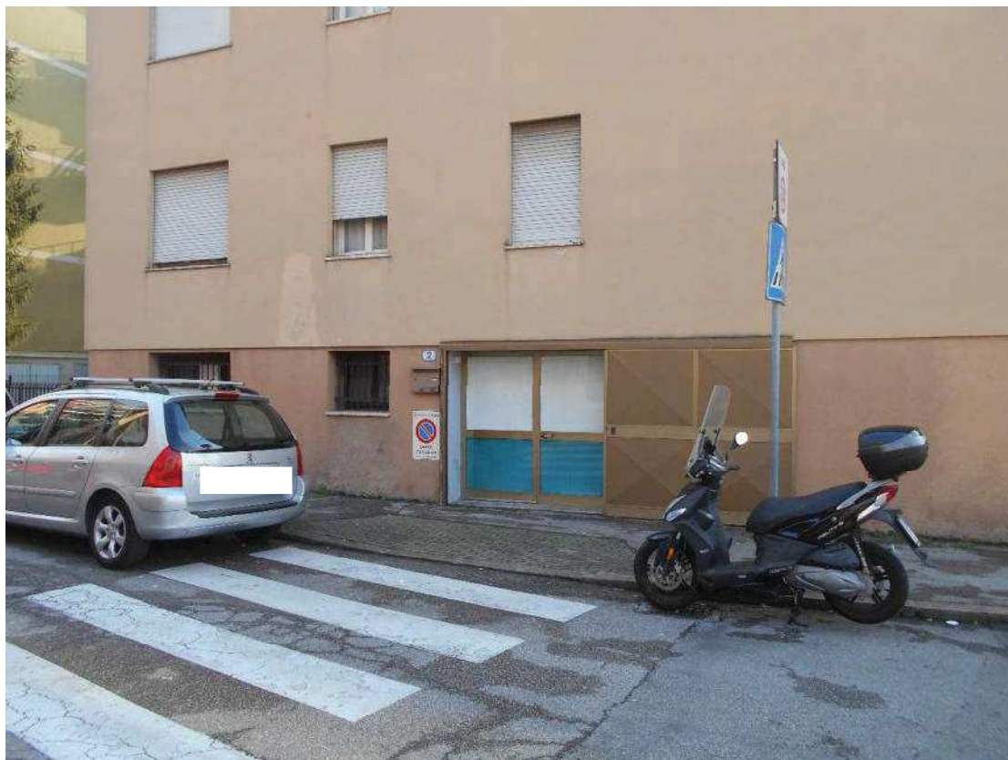
Foto 2: fabbricato condominiale, facciata nord-est, ingresso del magazzino
