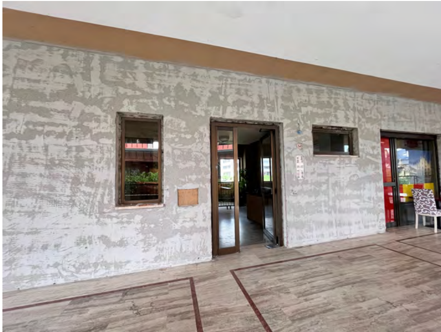
Immagine 0. Vista dell'ingresso al fabbricato e in particolare alla scala M dal portico che separa il fabbricato dalla pubblica via.
