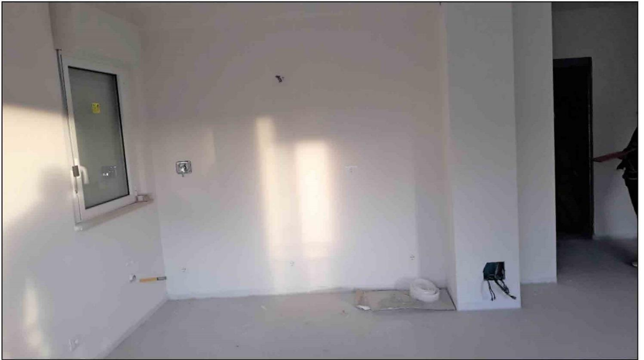
Lott n.3 - Foto n.7 – soggiorno
