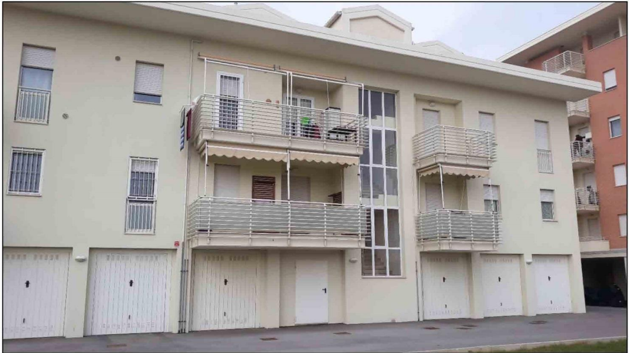
Lott n.3 - Foto n.3 – esterno fabbricato
