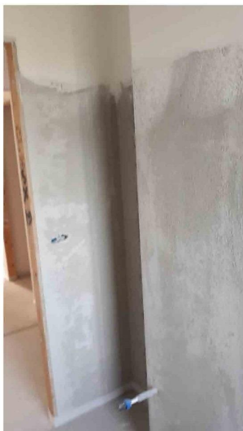
Lott n.3 - Foto n.18 – bagno
