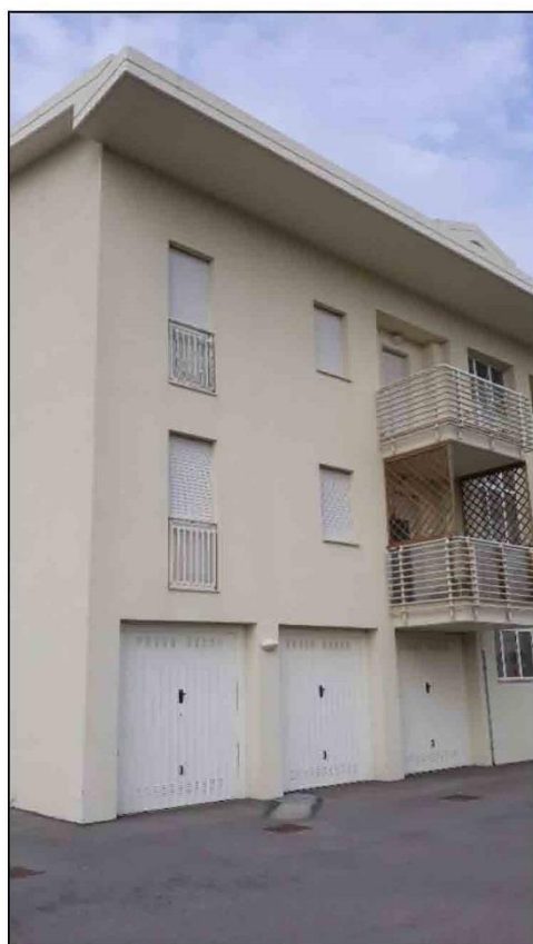
Lott n.2 - Foto n.2 – esterno fabbricato
