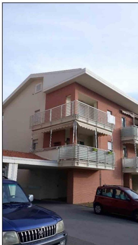
Lott n.3 - Foto n.2 – esterno fabbricato
