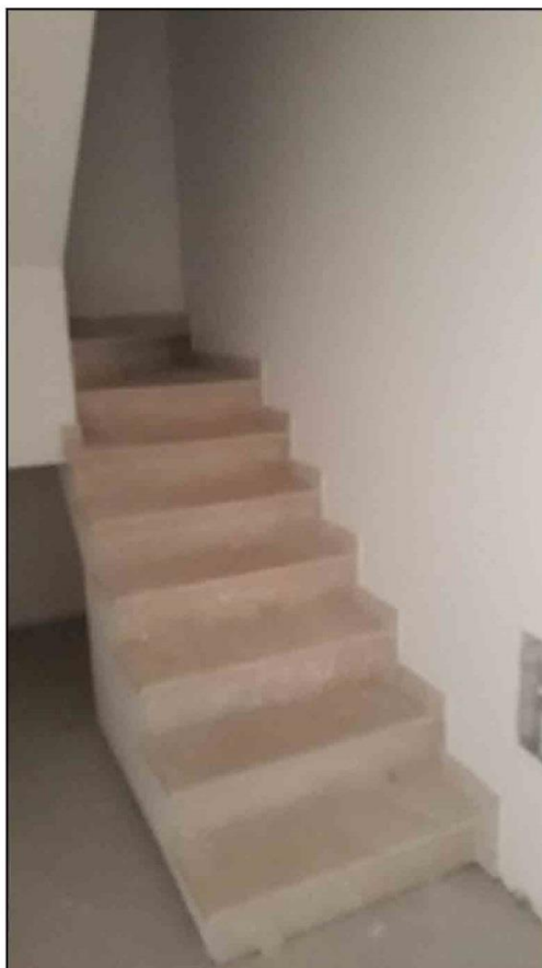
Lott n.3 - Foto n.22 – scala interna
