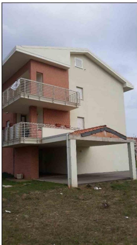
Lott n.2 - Foto n.1 – esterno fabbricato
