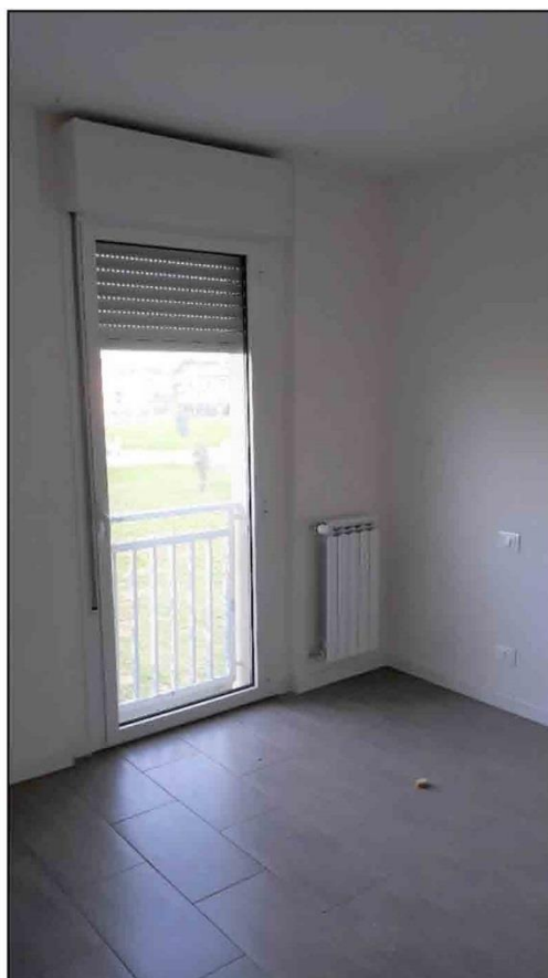
Lott n.2 - Foto n.19 – camera
