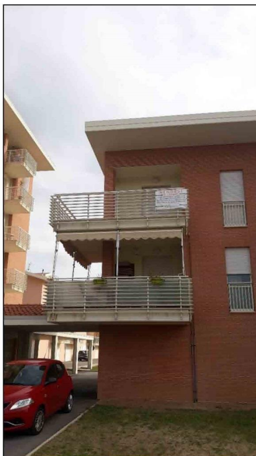
Lott n.3 - Foto n.1 – esterno fabbricato
