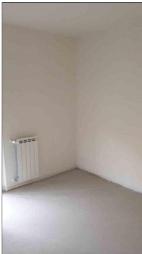
Lott n.3 - Foto n.21 – camera
