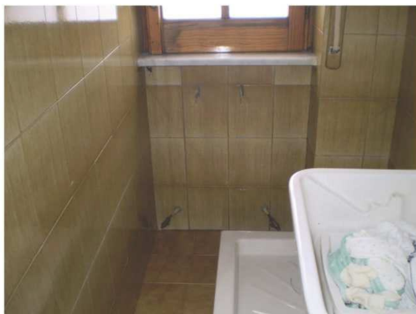
Foto n. 6– Vista interna - Bagno di servizio
