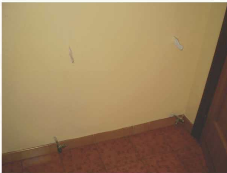
Foto n. 11 – Attacchi privi di elementi scaldanti
