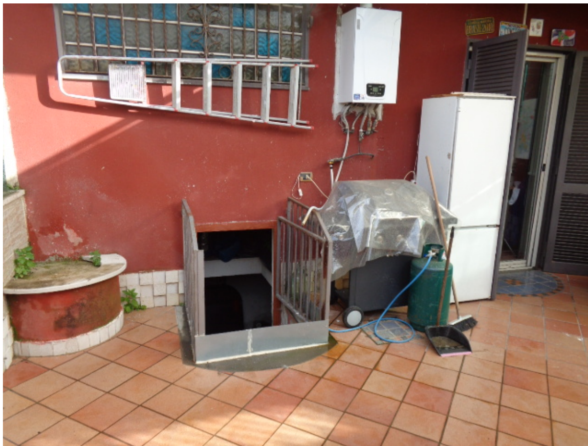
Foto n. 16: • Scaletta di accesso a sgabuzzino interrato.
