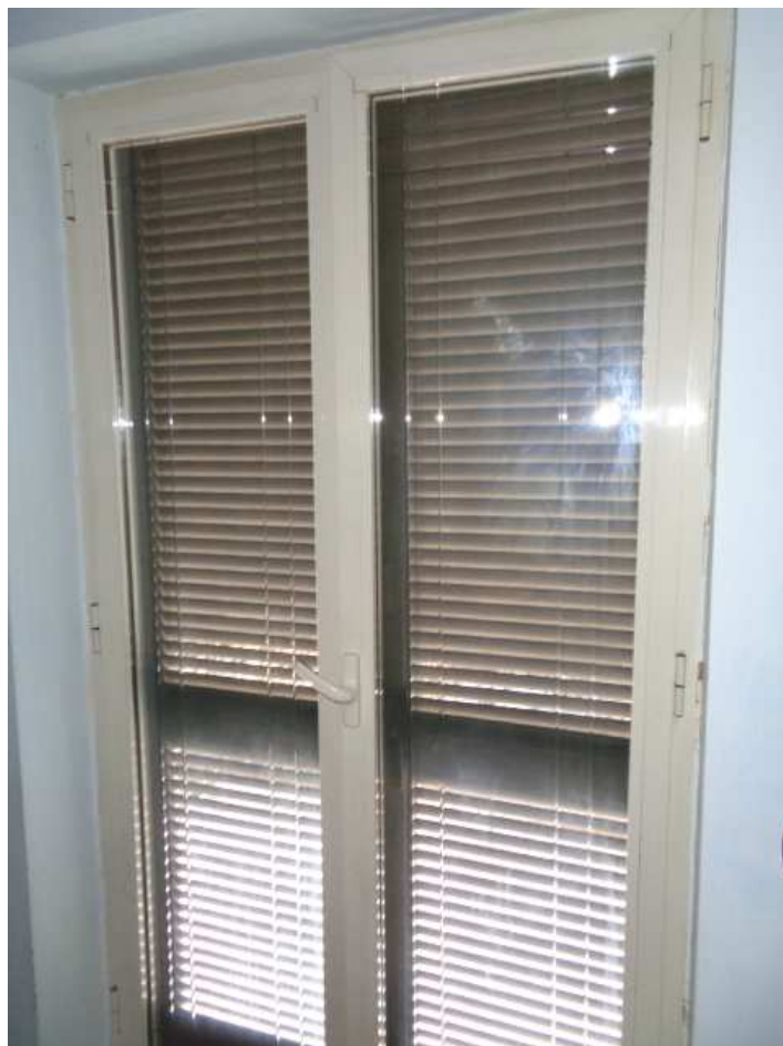
Foto n. 32: • Tipologia infissi esterni (particolare tipico).
