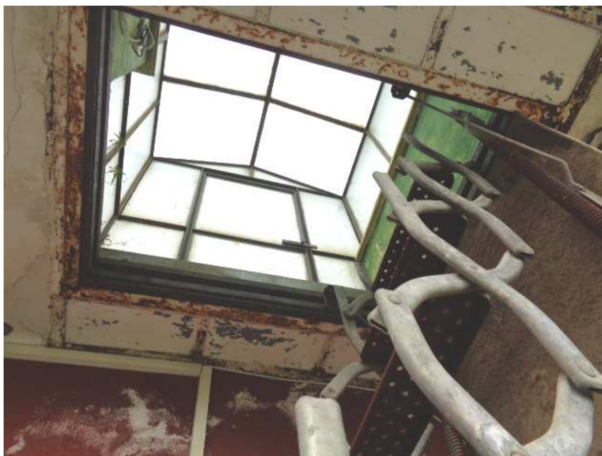
Foto n. 28: • Gabbio in vetro di accesso al lastrico solare.
