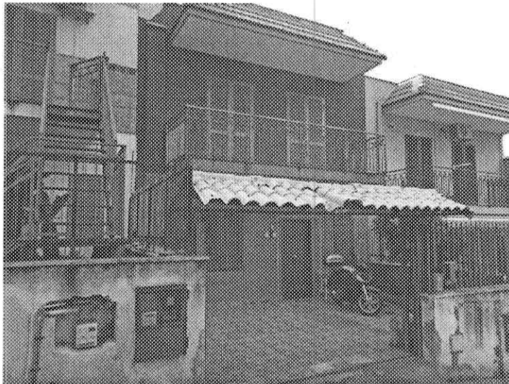
Foto n. 2: • Prospetto principale, varco di accesso (non meglio contrassegnato) e cortile pertinenziale.
