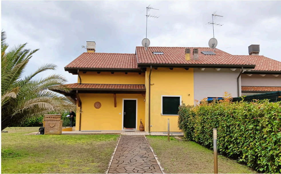
Foto 3: Prospetto Nord con l'ingresso all'abitazione
