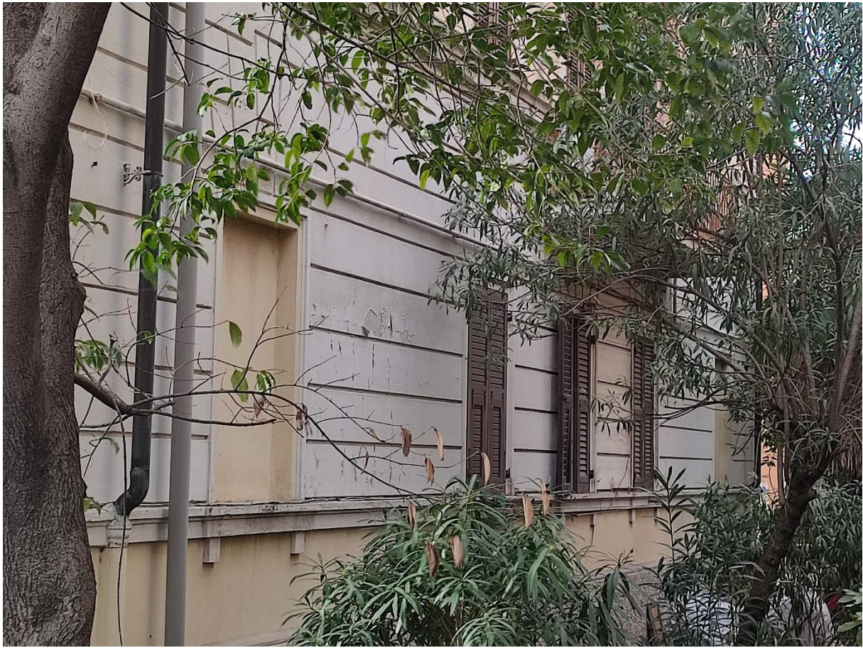
LE FINESTRE SUL DISTACCO NORD
