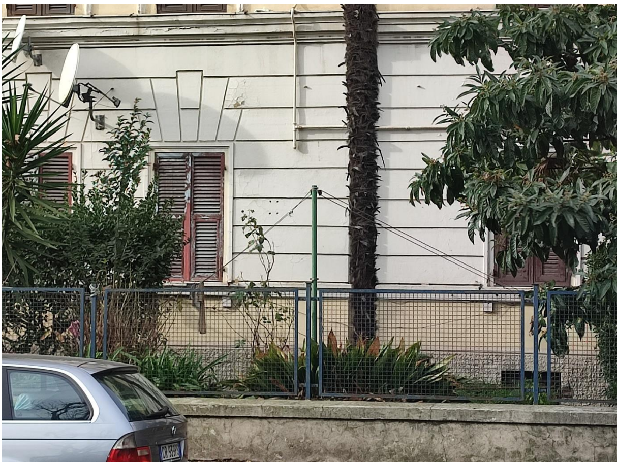
LE FINESTRE SU VIA WALTER FILLAK
