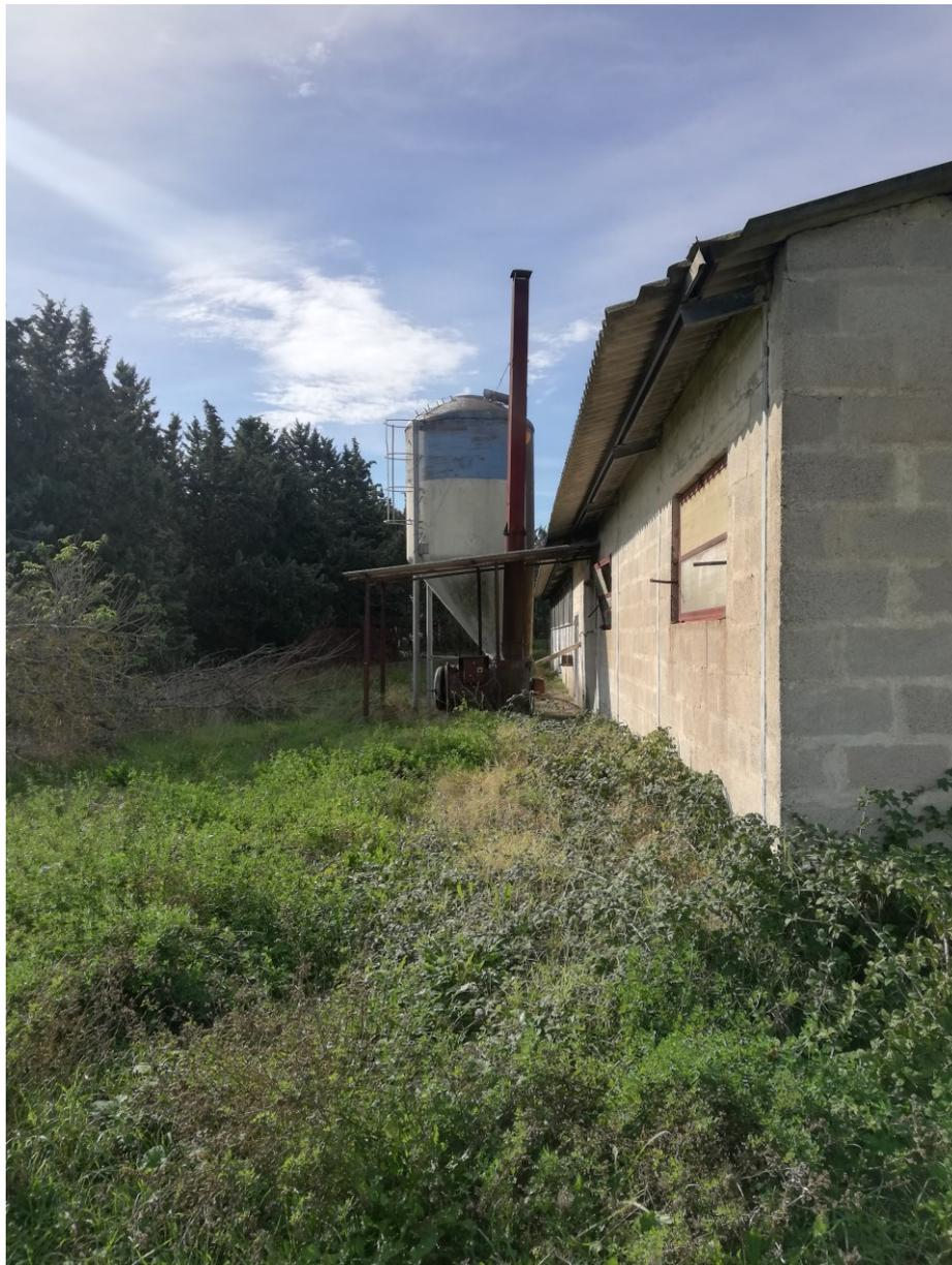
Il fabbricato C) – Capannone di allevamenti - è stato realizzato con struttura in muratura portante contenute da profilati in ferro, su fondazione continua, con solai di copertura, in lastre di fibra cemento-amianto su struttura in ferro.
