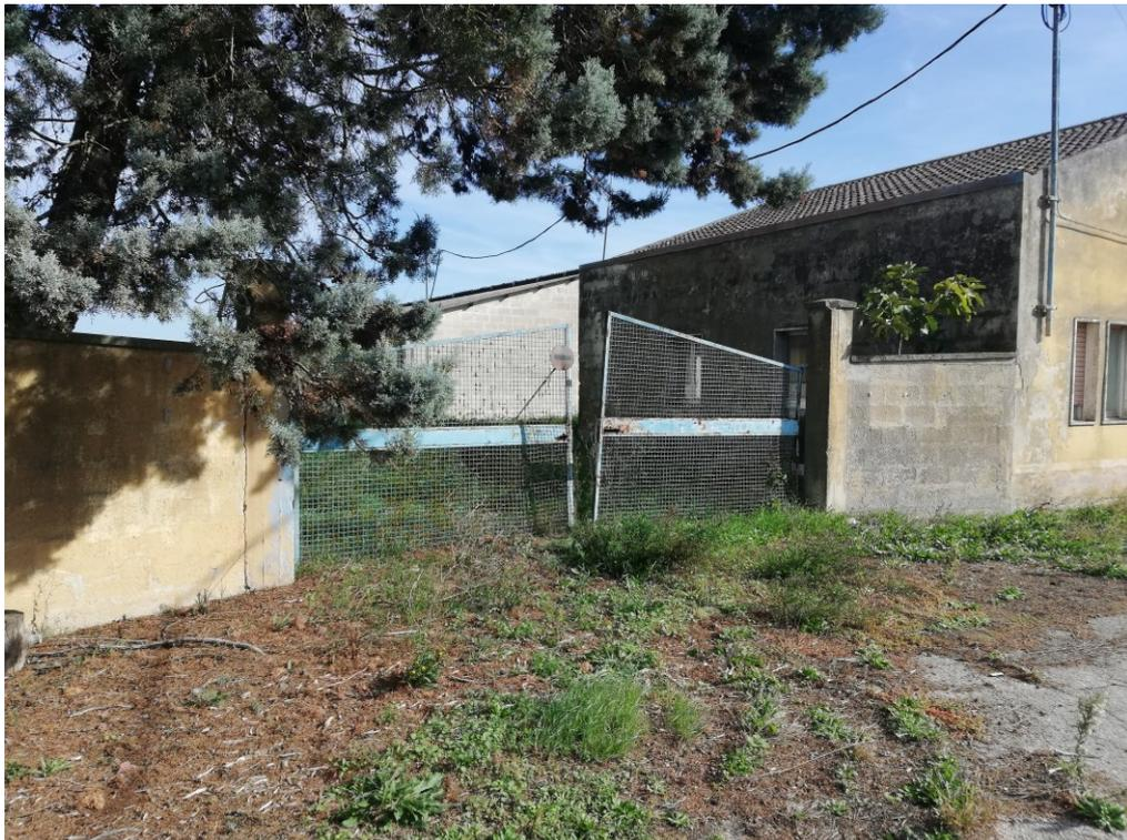
Perimetralmente è delimitata da recinzione in pali di ferro e rete metallica su cordolo in c.a. Con eccezione sul prospetto Nord-Est dove la chiudenda è in pali di cemento e filo spinato.
