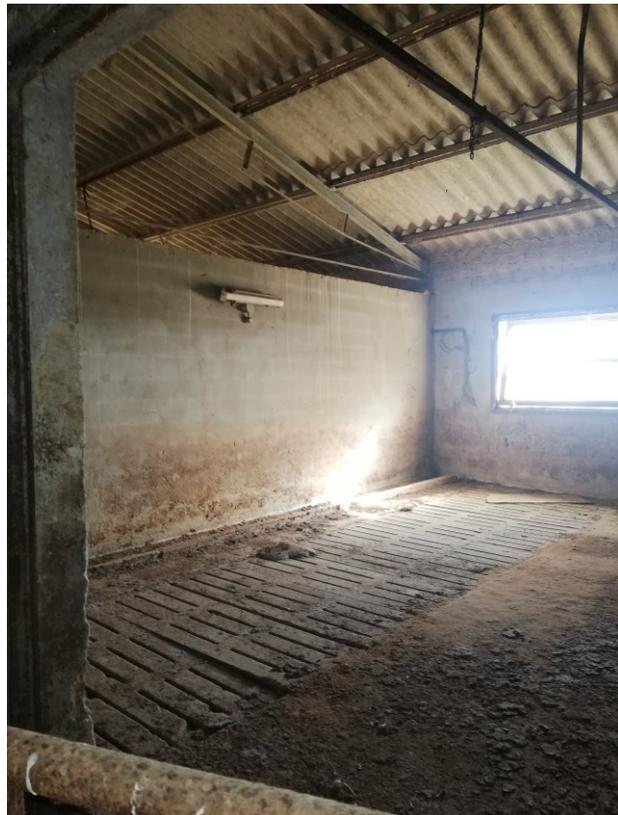
Lo stato di finitura e la dotazione di impianti sono minimali, indicati per la destinazione d'uso di stalla; gli infissi sono in lamiera di ferro con vetri singoli.
