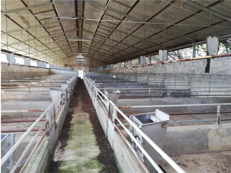
Lo stato di finitura e la dotazione di impianti sono minimali, indicati per la destinazione d'uso di stalla; gli infissi sono in lamiera di ferro con vetri singoli.
