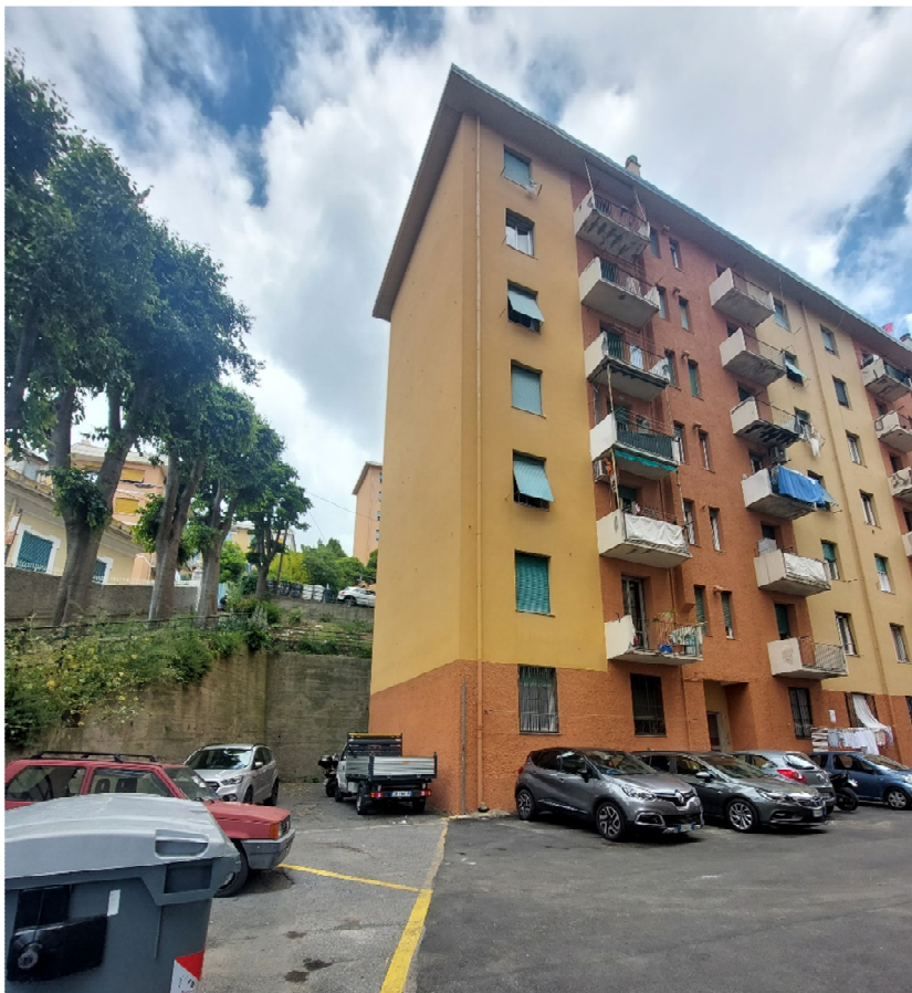
FOTO 4: vista prospetto laterale
