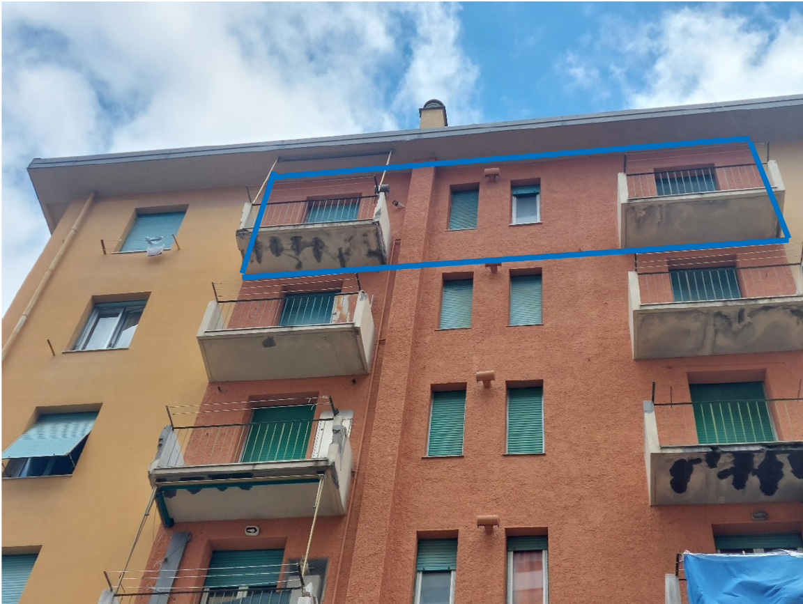
FOTO 3: prospetto principale - in evidenza gli affacci dell'u.i. interno 19
