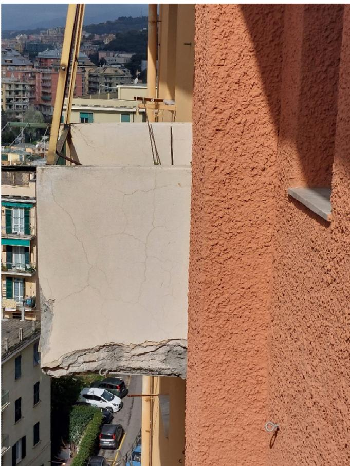
FOTO 19: stato di degrado dei balconi
