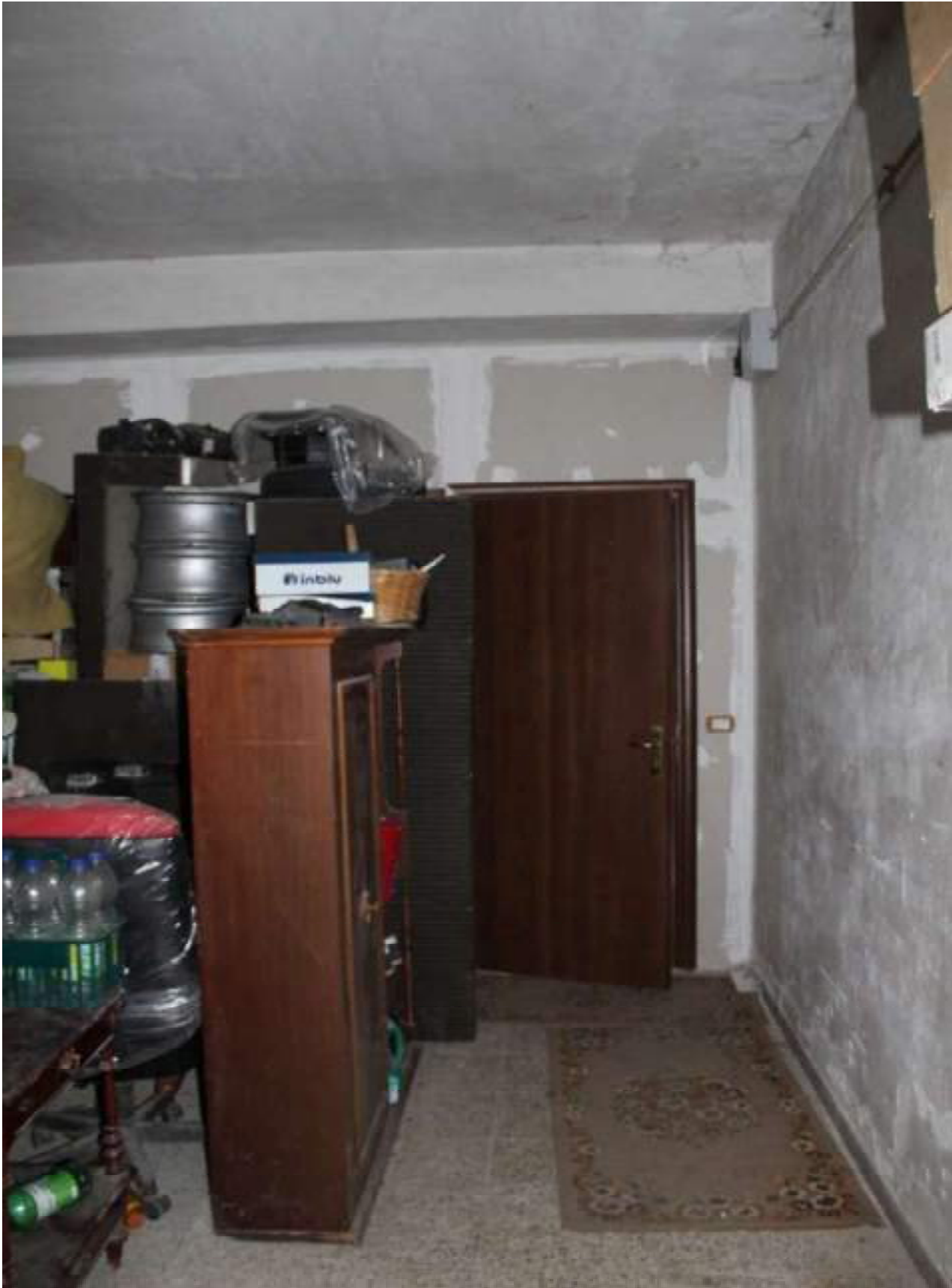
parete e posta ingresso al piano seminterrato dell'attuale alloggio del sig Cariatì Carlo (da rimuovere)
