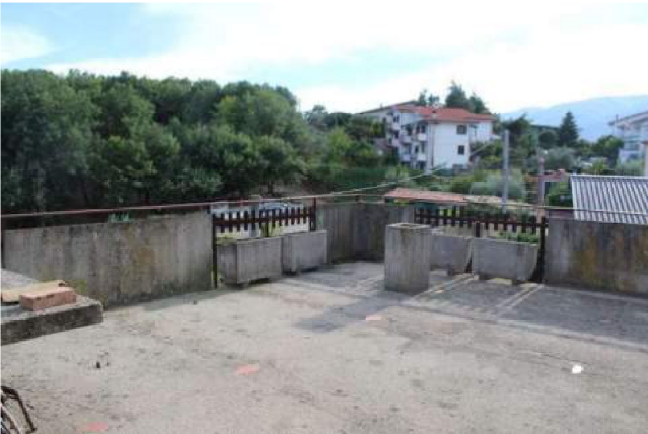
vista terrazzo piano sottotetto
