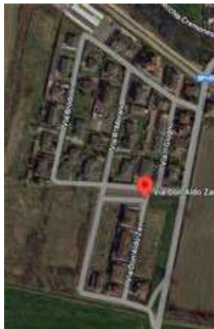
vista aerea (fuori scala)
