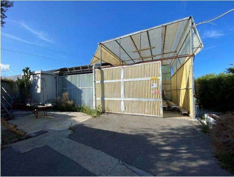
Struttura precaria "capo serra" lato est
