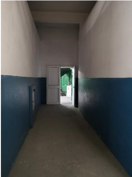
Foto 6: passaggio tra le celle frigorifere
