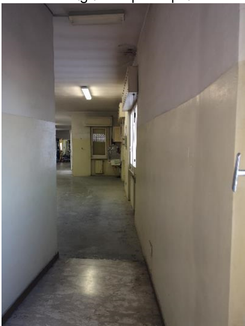
Foto 15: magazzino primo piano:
