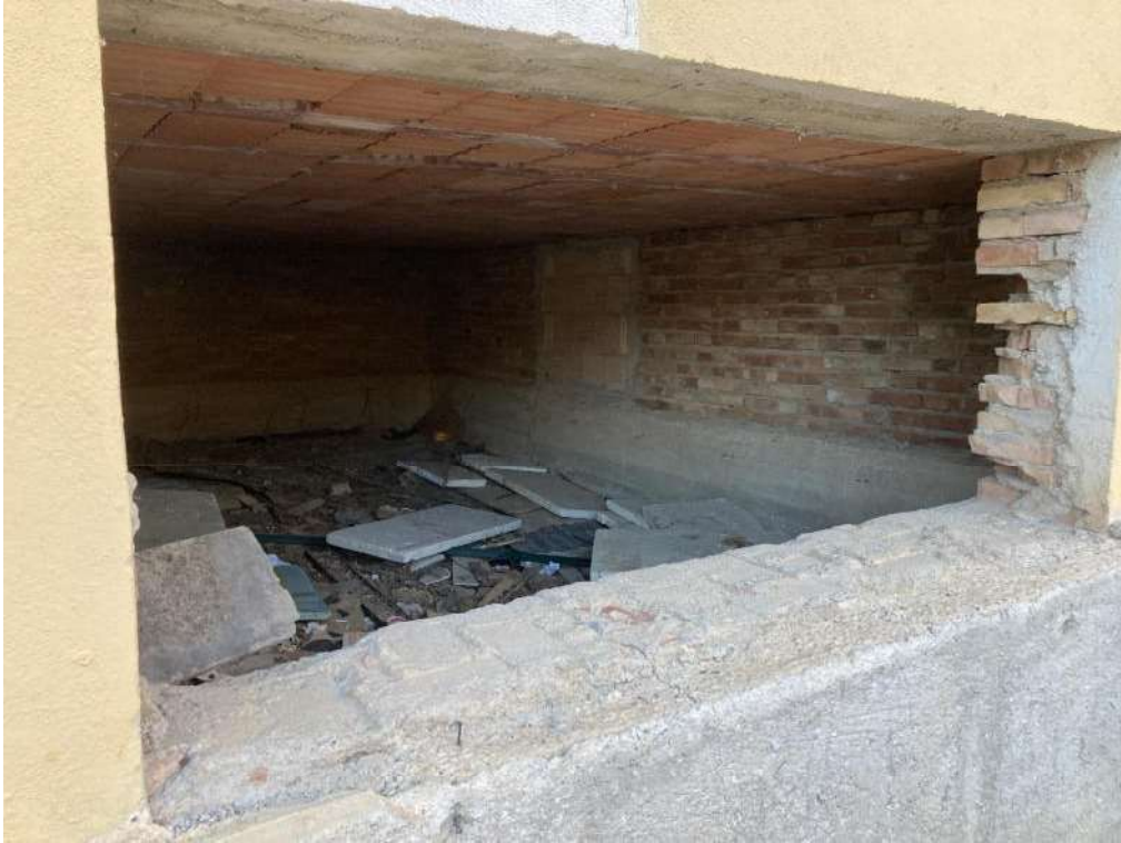
Foto 6 – Particolare apertura vano tecnico seminterrato lato est
