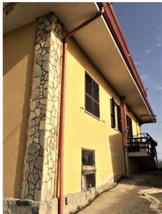
Foto 5 – Particolare prospetto est
