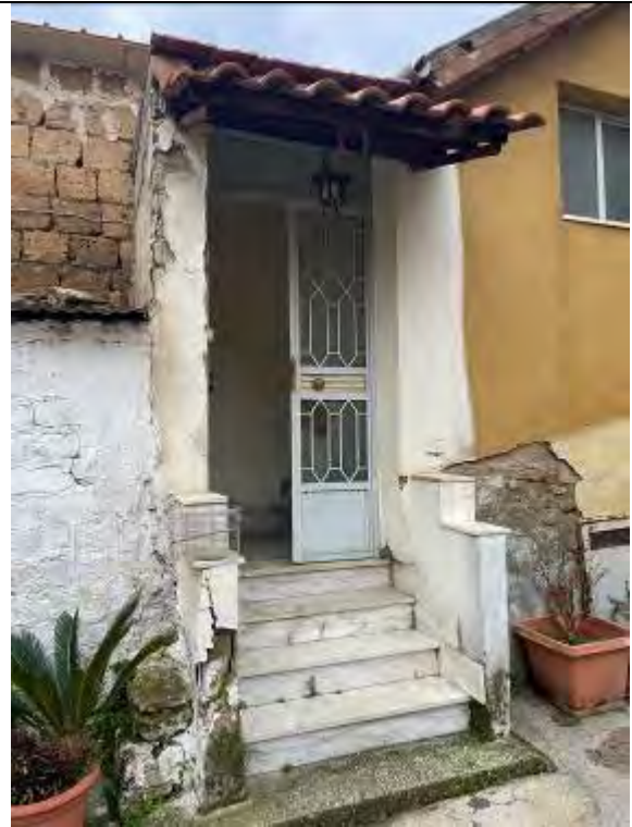
Fotografia n. 4 _ Scala di accesso al LOTTO UNICO
