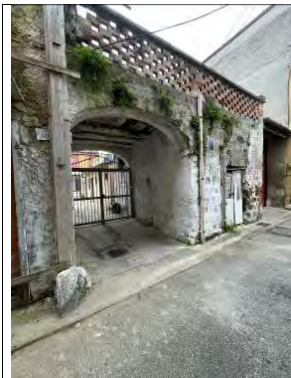
Fotografia n. 1 _ Androne di accesso
