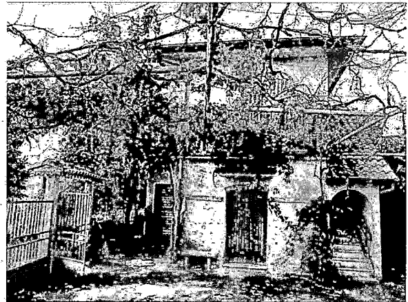
fabbricato di via Cappellato II
