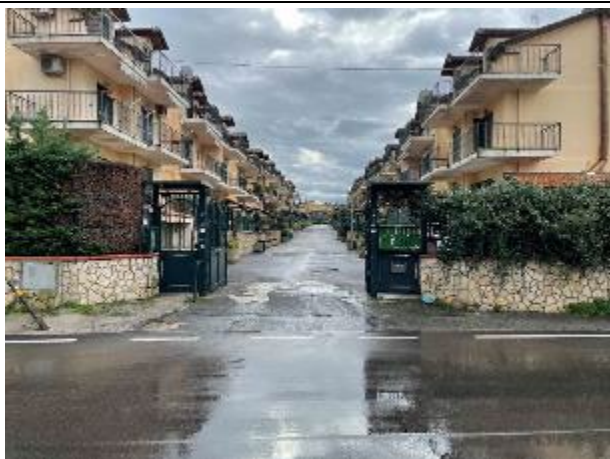
Vista ingresso condominio dalla strada
