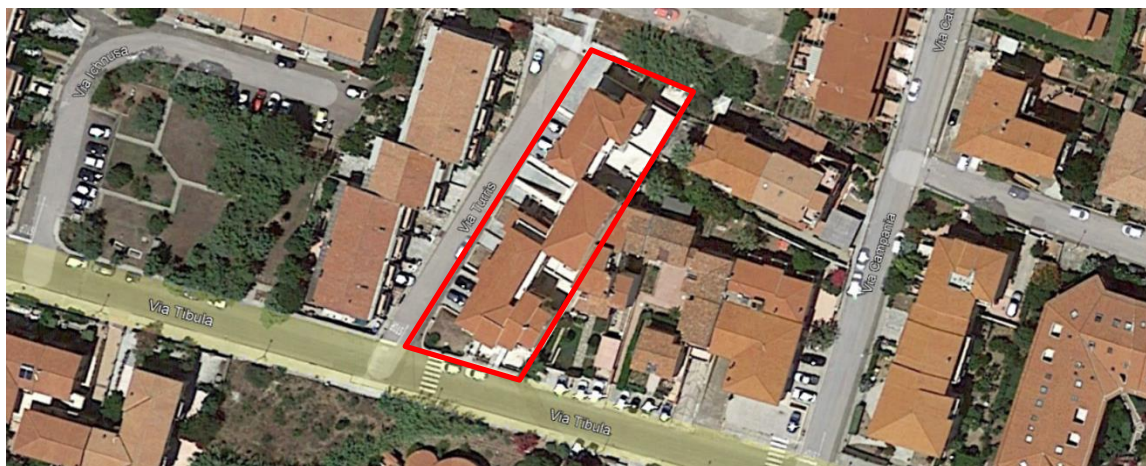
Figura 5 – Ubicazione – Santa Tresa di Gallura - il perimetro rosso segnala l'ingombro planimetrico del compendio nel quale sono allocati i beni immobiliari oggetto di procedura esecutiva
