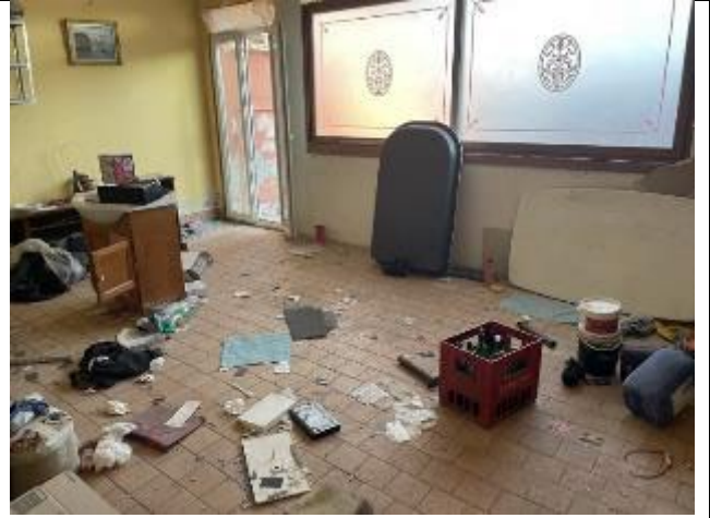
Vista locale deposito pianon terra
