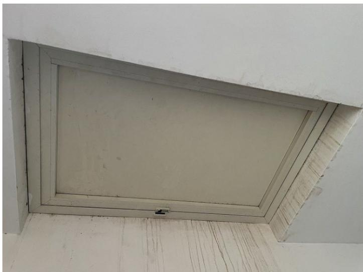
sono visibili macchie da dilavamento delle acque che si infiltrano dalla copertura.
