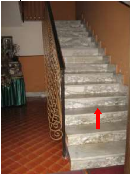
Figura 10 vano scala di accesso ai piani del fabbricato
