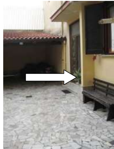
Figura 9 androne e cortile comune di accesso al vano scala del fabbricato in cui è sito l'immobile pignorato
