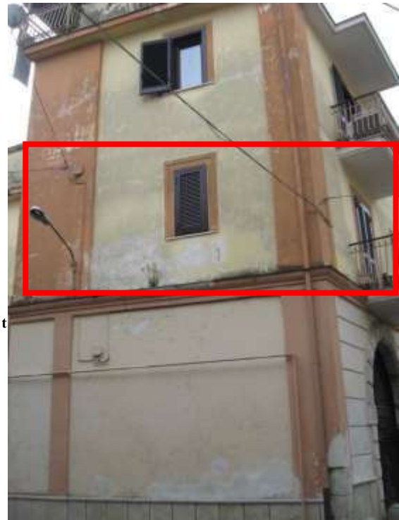
Figura 7 facciata est del fabbricato in cui è situato l'appartamento
