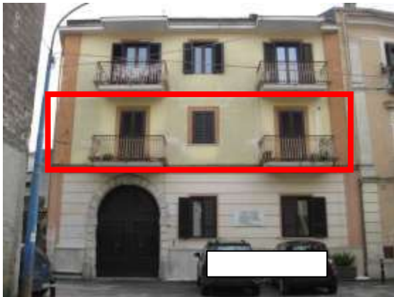
Figura 6 facciata nord del fabbricato prospiciente piazzetta Annibale Ranucci in Sparanise
