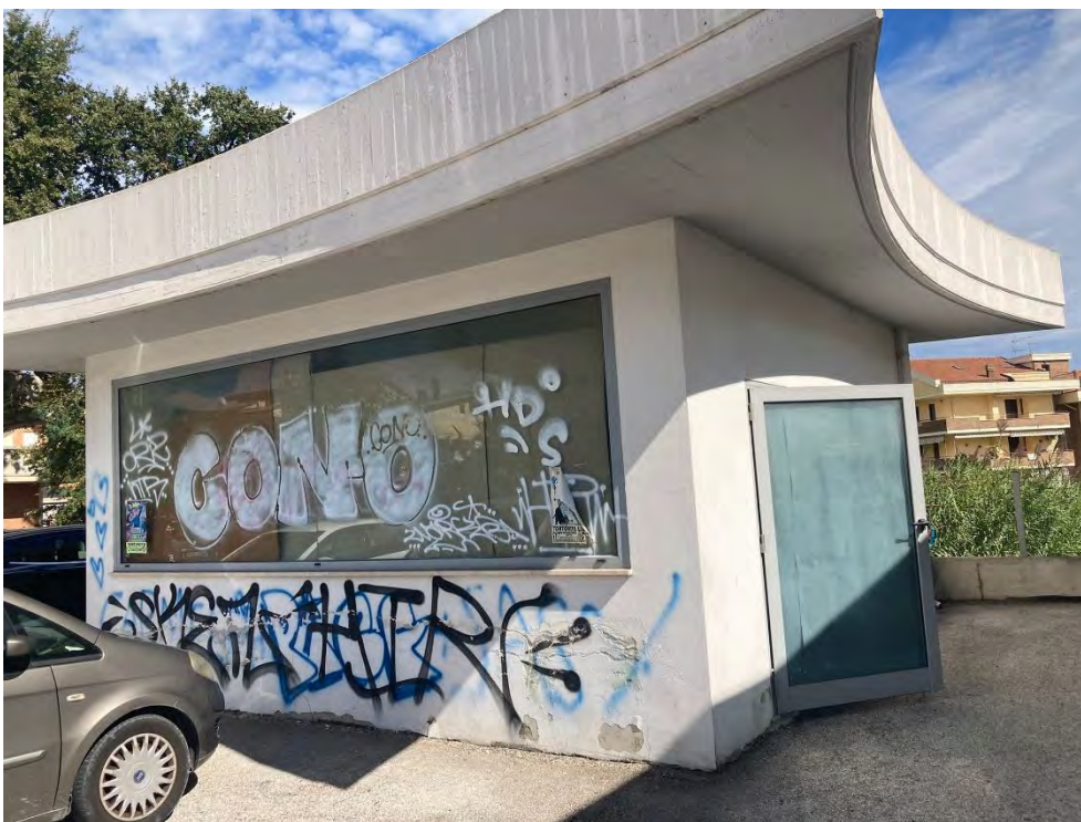
Foto riferite al sub. 13 BCNC a servizio dei LOTTI n. 8 e n. 9
