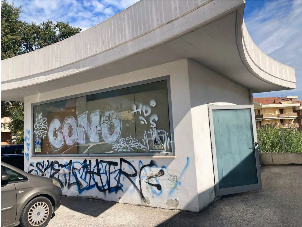
Foto riferite al sub. 13 BCNC a servizio dei LOTTI n. 8 e n. 9
