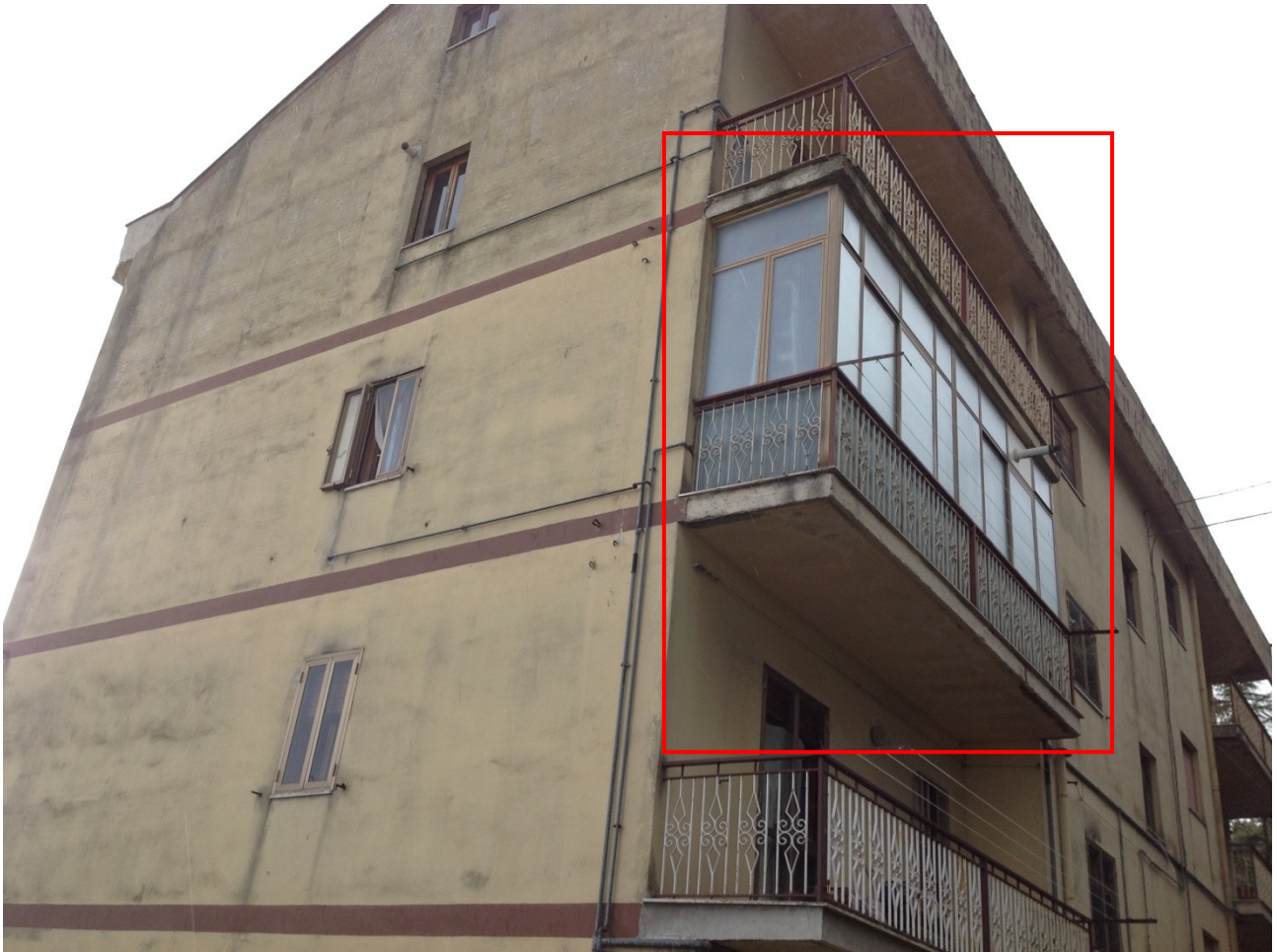
Figura 12. LOTTO 1: Immobile pignorato - abitazione al F. 43, P.IIa 246, sub. 5 ubicato in Bovino alla Via Giovanni Boccaccio n. 3 (balcone chiuso).
