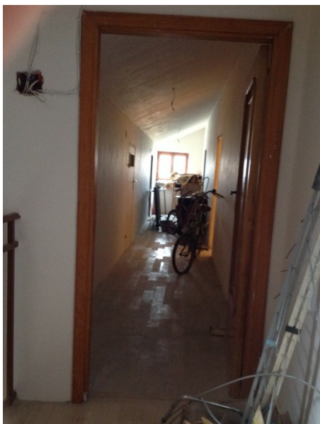
Figura 15. LOTTO 2 - 3: Immobili pignorati - depositi al F. 43, P.IIa 246, sub. 10 e 11 ubicati in Bovino alla Via Giovanni Boccaccio n. 3 (corridoio).
