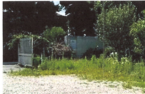
Vista cabina da cortile pertinenziale
