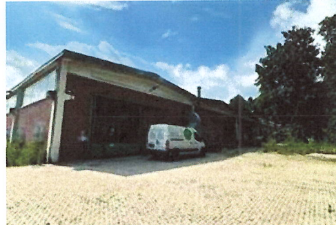
Vista fronte est
