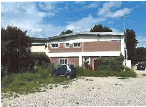
Vista fronte ovest
