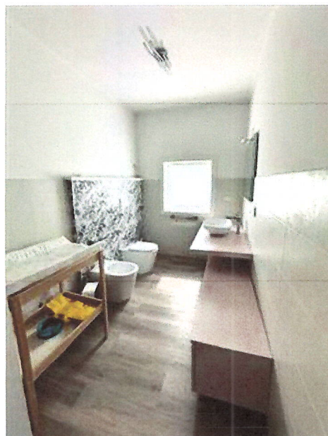
Vista bagno (PI)
