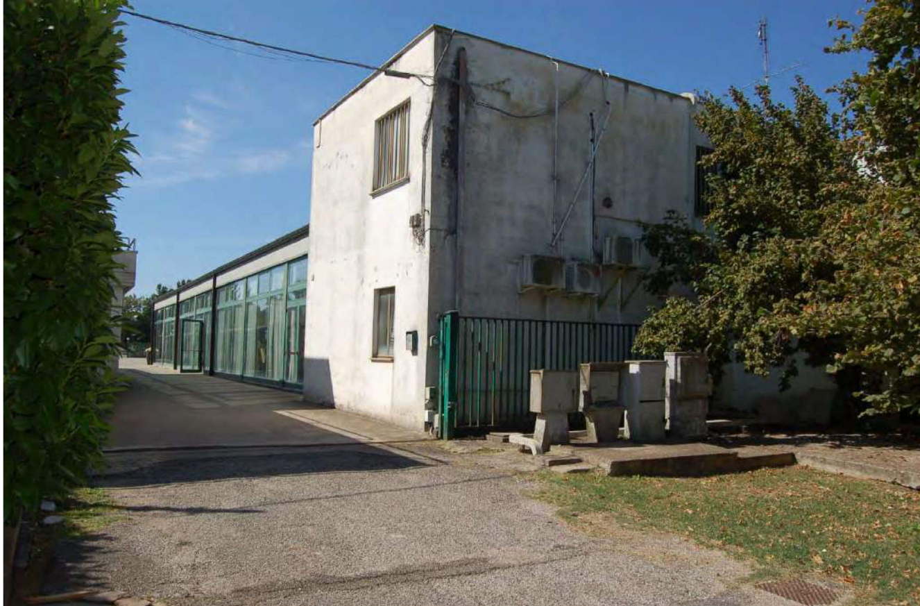
Foto 21 - Ingresso posteriore al compendio pignorato da proprietà di terzi
