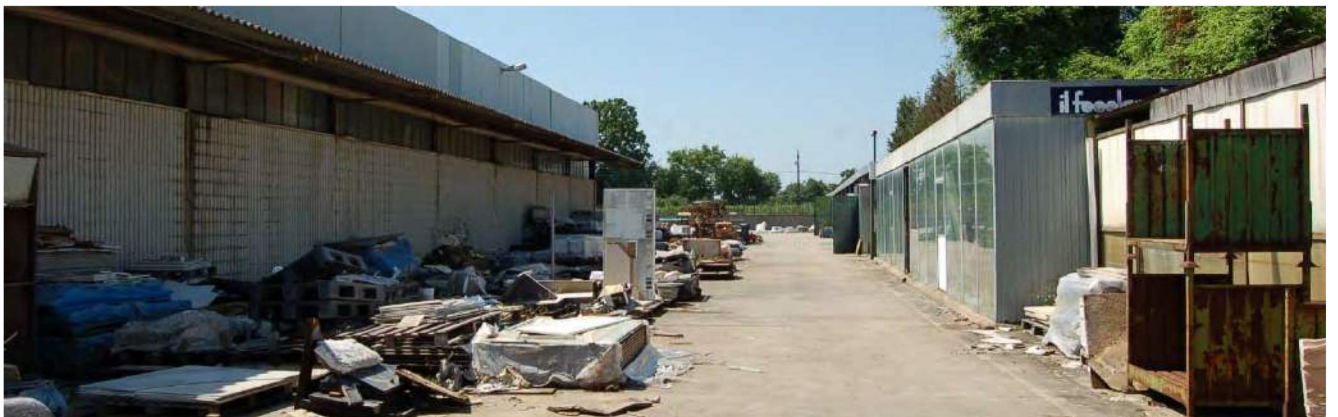
Foto 16 - Vista d'insieme del corpo di fabbrica principale e delle aree esterne
