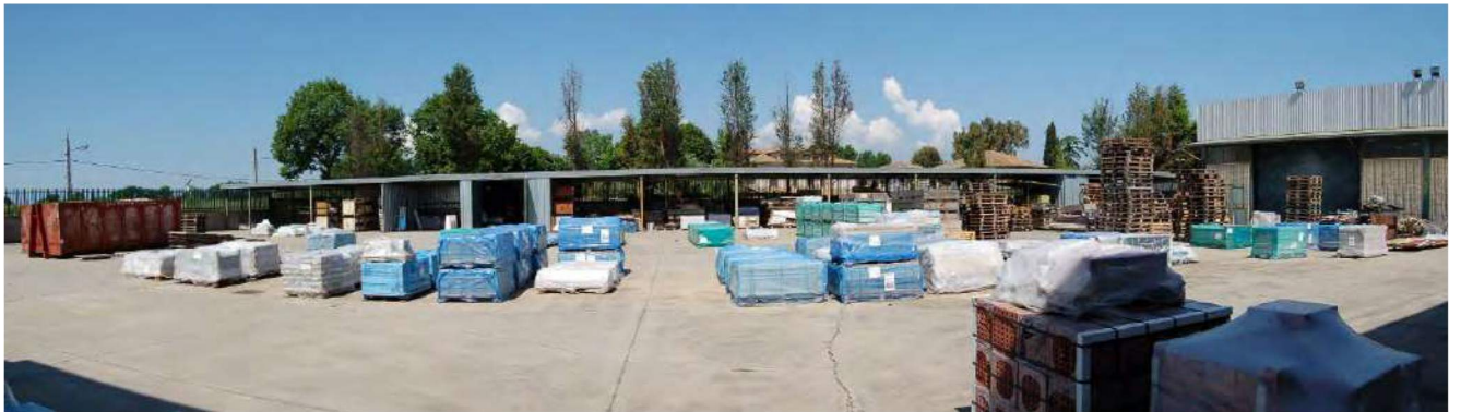
Foto 15 - Vista d'insieme del corpo di fabbrica principale e delle aree esterne
