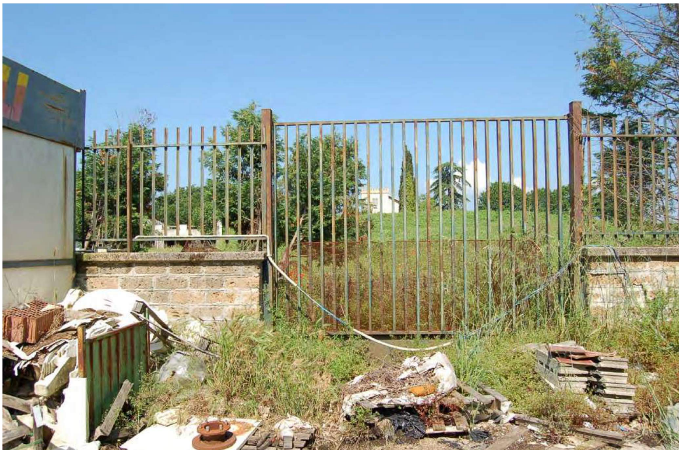
Foto 18 - Ingresso posteriore al compendio pignorato da proprietà di terzi
