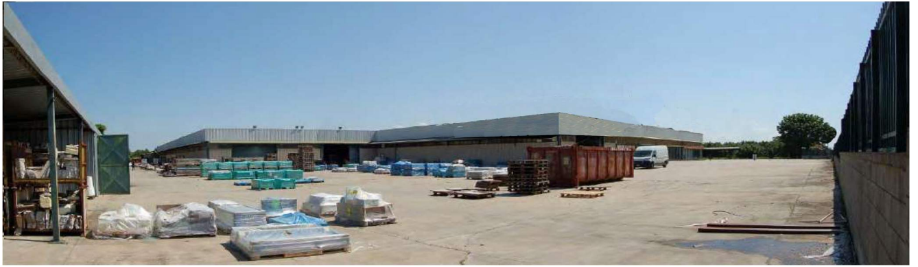
Foto 14 - Vista d'insieme del corpo di fabbrica principale e delle aree esterne
