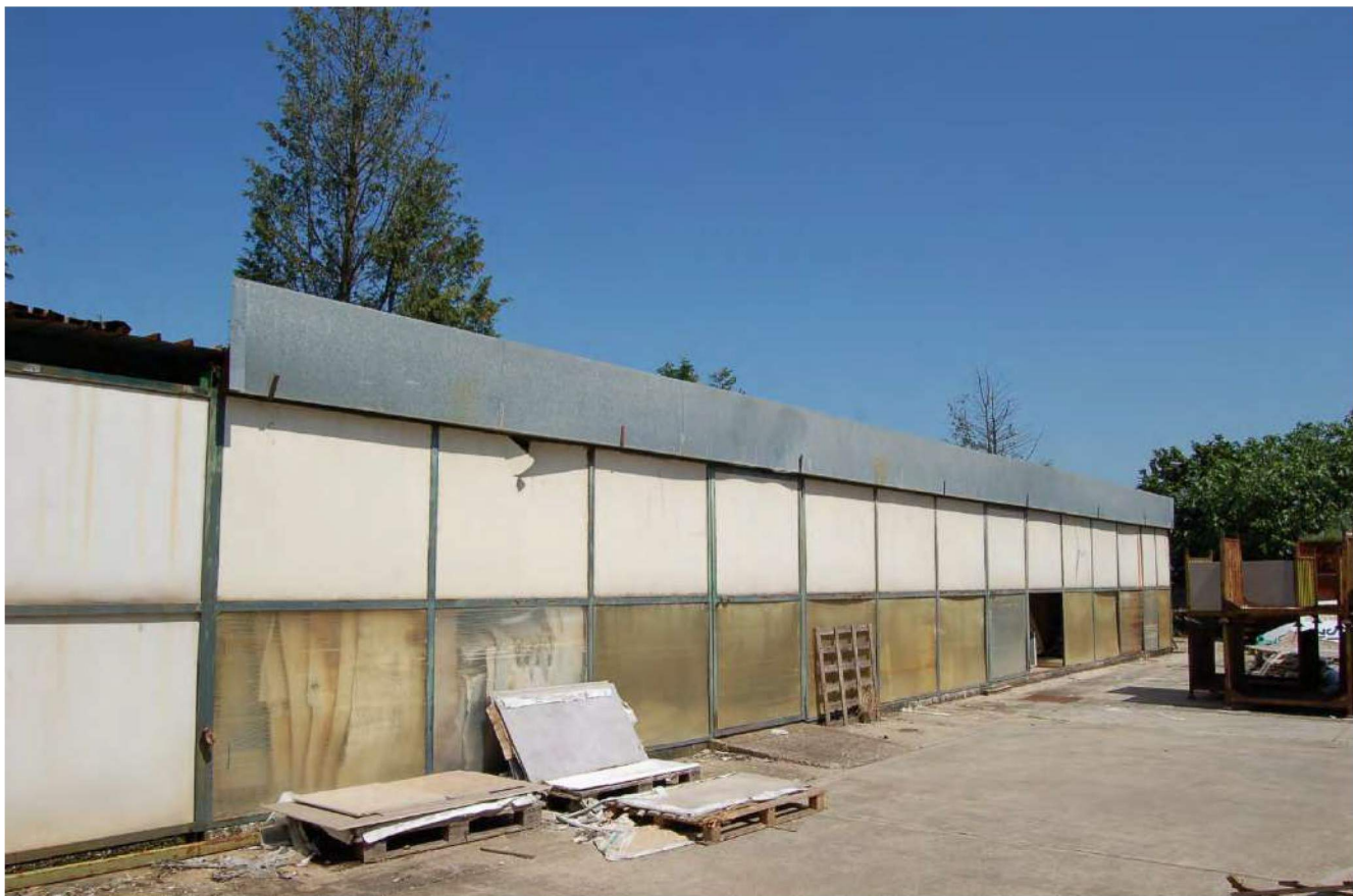
Foto 7 - Corpo di fabbrica D – Prima porzione
