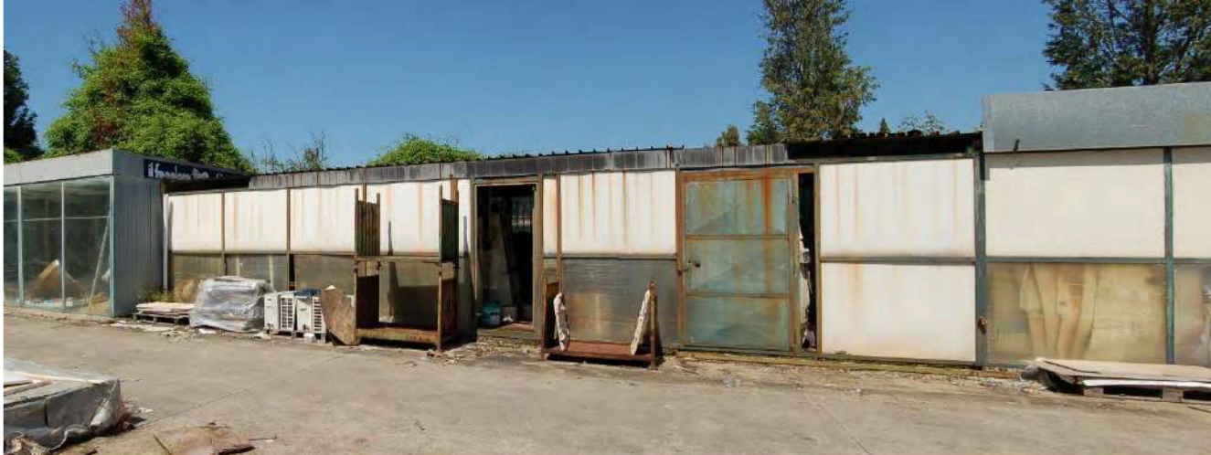
Foto 8 -Corpo di fabbrica D – Seconda porzione
