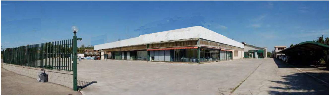
Foto 13 - Vista d'insieme del corpo di fabbrica principale e delle aree esterne
