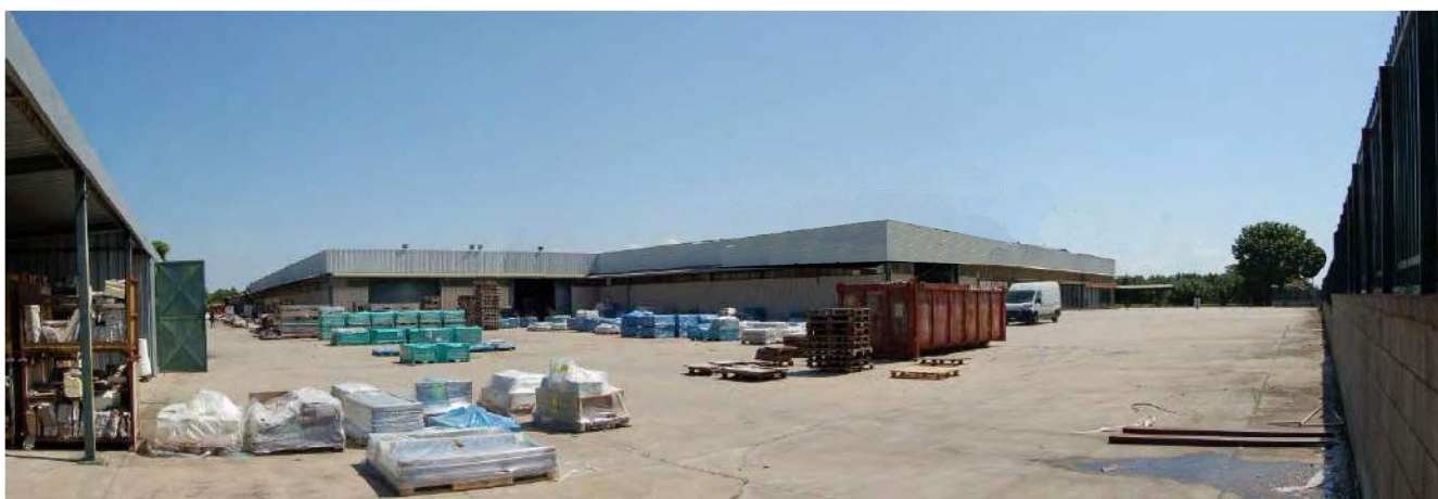
Foto 3 - Corpo di fabbrica A - Scorcio prospettico ovest
