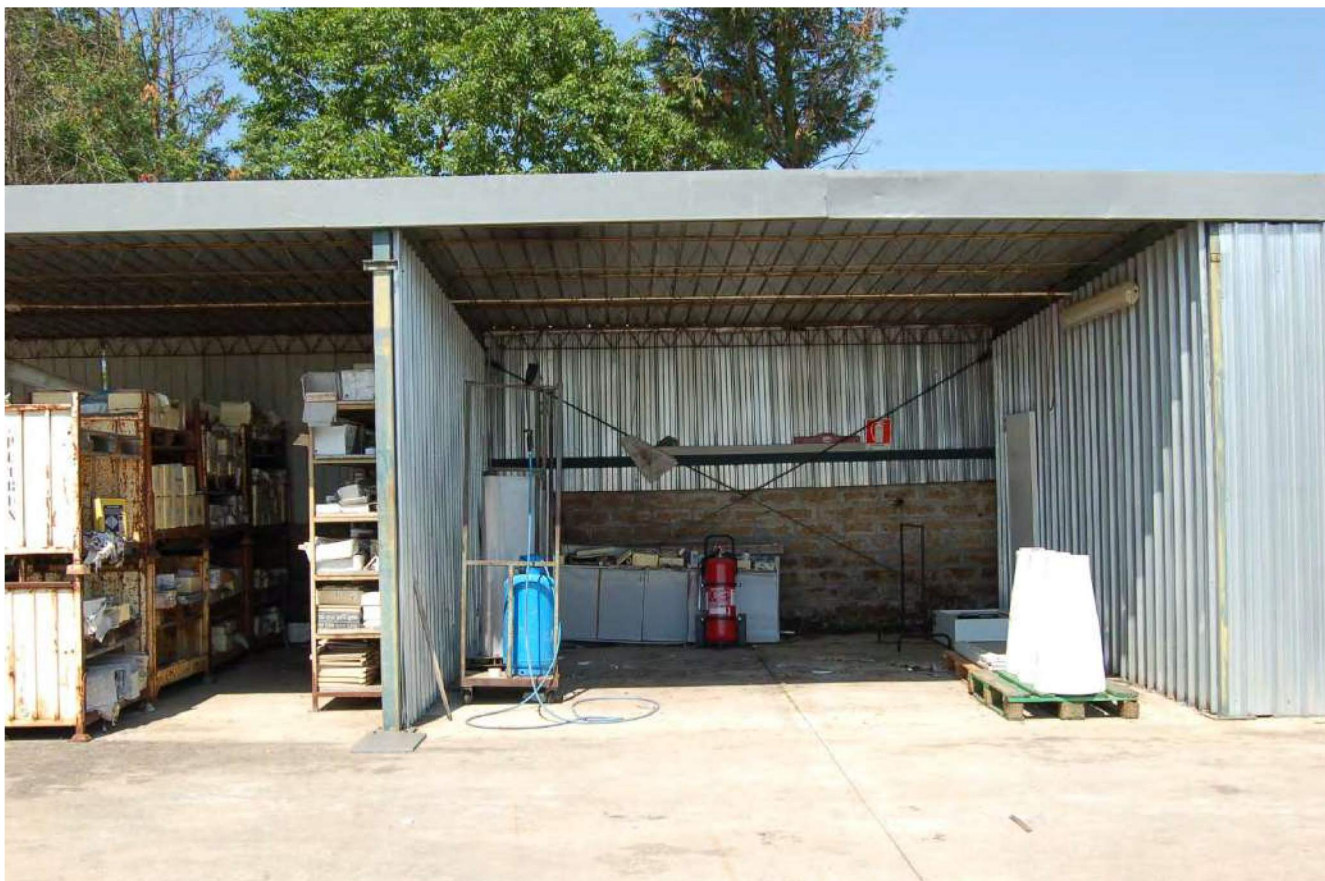
Foto 178 - Stralcio della tettoia 3
