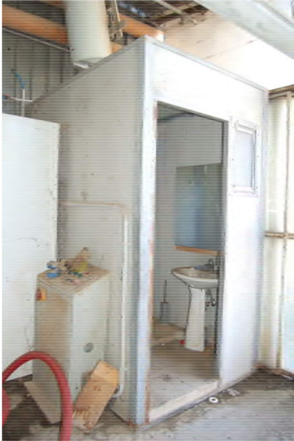
Foto 183 – Vista del bagno interno al magazzino
