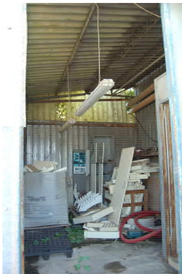
Foto 182- Vista interna del magazzino
