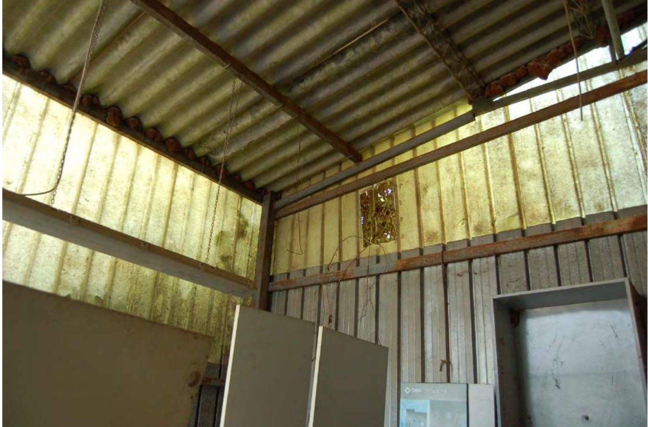
Foto 185 - Vista interna delle pareti perimetrali
