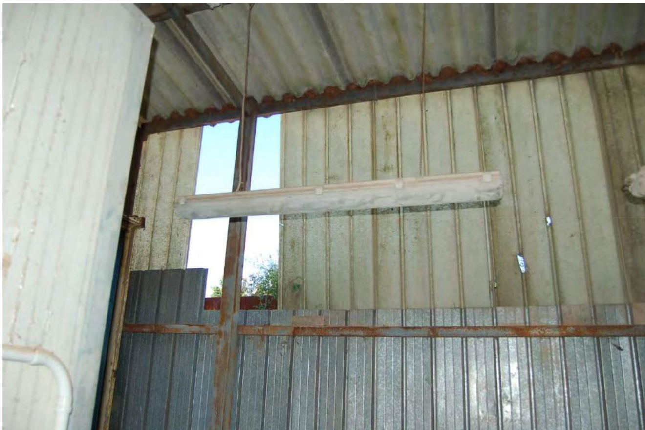
Foto 184 - Vista interna delle pareti perimetrali
