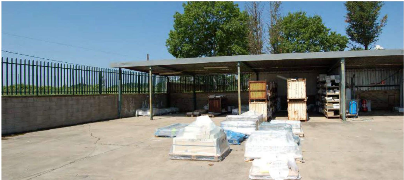
Foto 179 - Stralcio della tettoia 3
