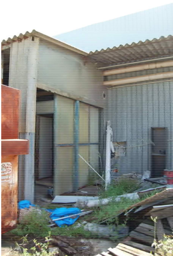
Foto 181 – Vista dell'accesso al magazzino
