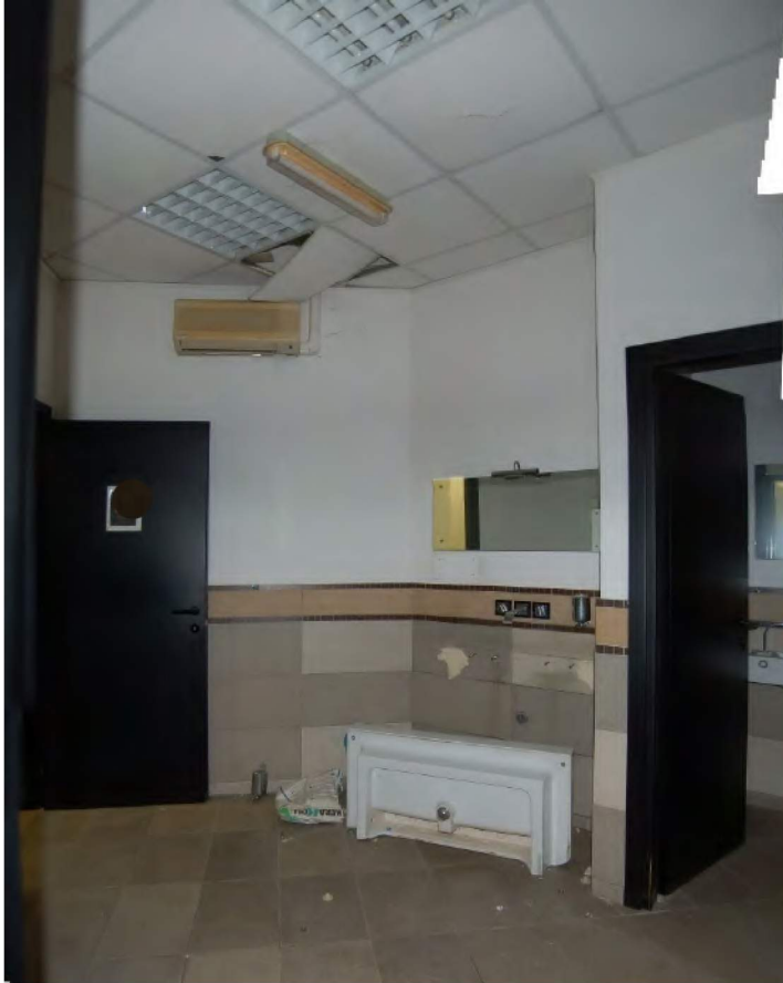
Foto 123 - Vista antibagno blocco bagni zona espositiva A4 in prossimità della sala giochi bambini
