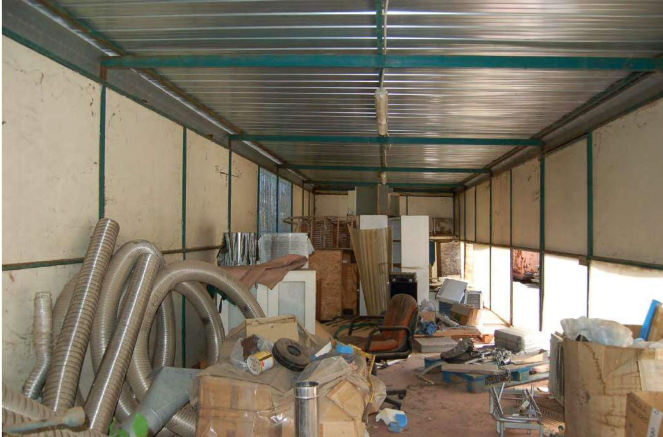
Foto 156 - Vista interna magazzino 1
