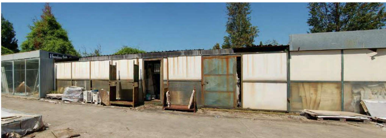
Foto 157 - Vista d'insieme della seconda porzione del corpo di fabbrica
