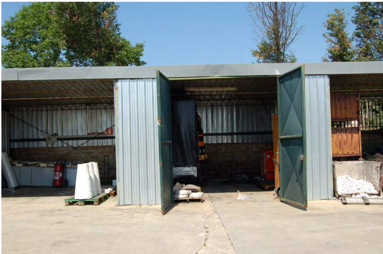
Foto 175 - Prospetto esterno magazzino 6
