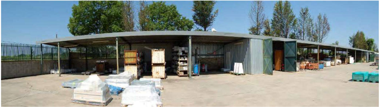
Foto 168 - Vista d'insieme della quarta porzione del corpo di fabbrica
