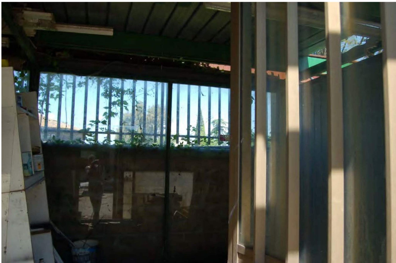
Foto 163 - Vista interna magazzino 3 con accesso dalla porta a battuta
