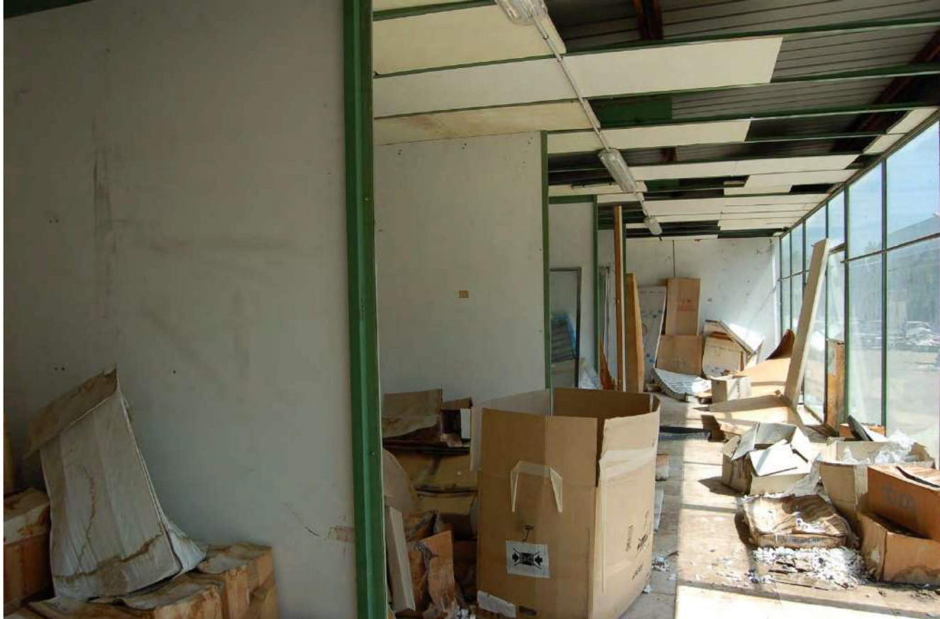
Foto 166 - Vista interna magazzino 4
