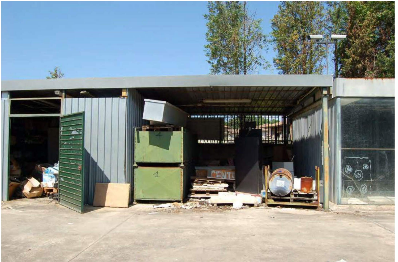
Foto 169 - Prospetto esterno tettoia 1
