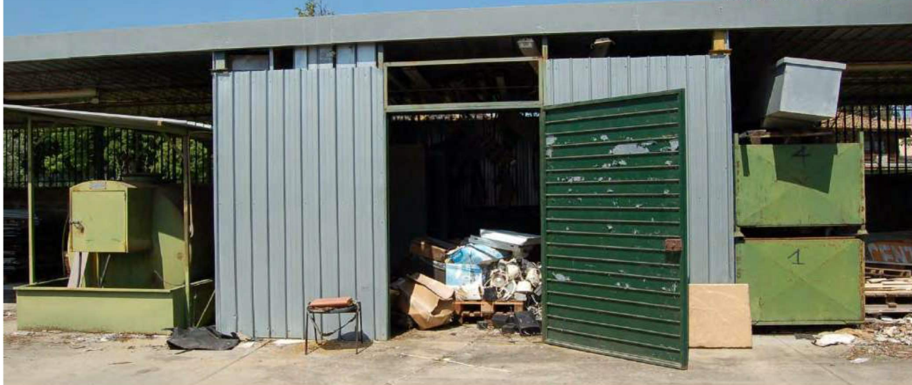
Foto 170 - Prospetto esterno magazzino 5
