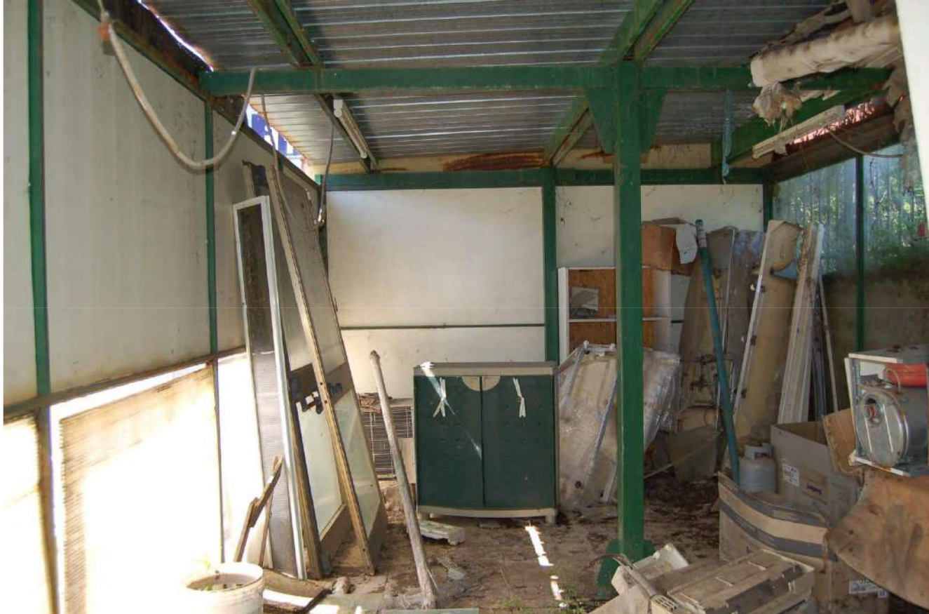
Foto 160 - Vista interna magazzino 3 con accesso dalla porta a battuta
