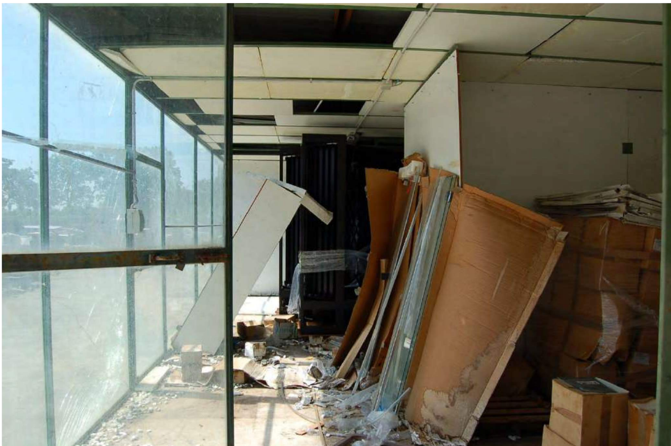
Foto 165 – Vista interna magazzino 4
