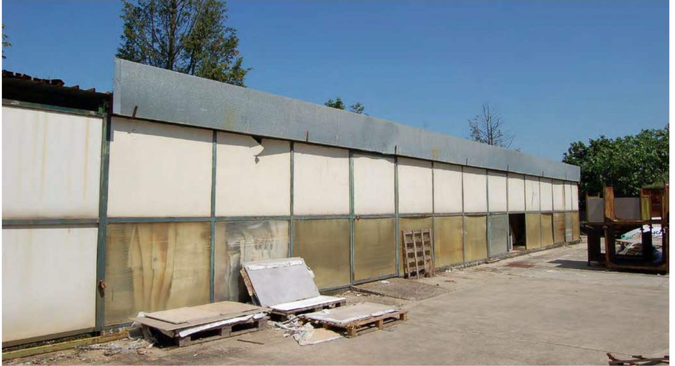
Foto 154 - Vista d'insieme della prima porzione del corpo di fabbrica
