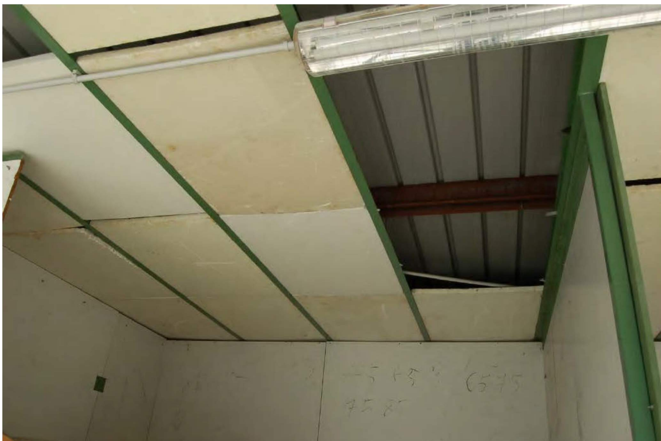
Foto 167 - Vista di dettaglio della copertura del magazzino 4
