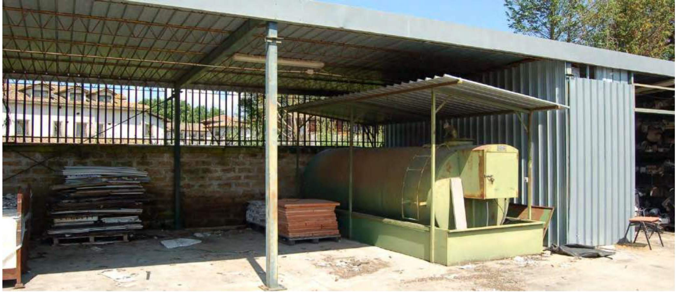
Foto 172 – Stralcio della tettoia 2
