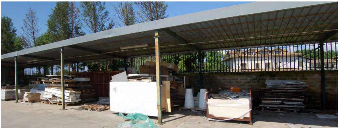
Foto 173 - Stralcio della tettoia 2
