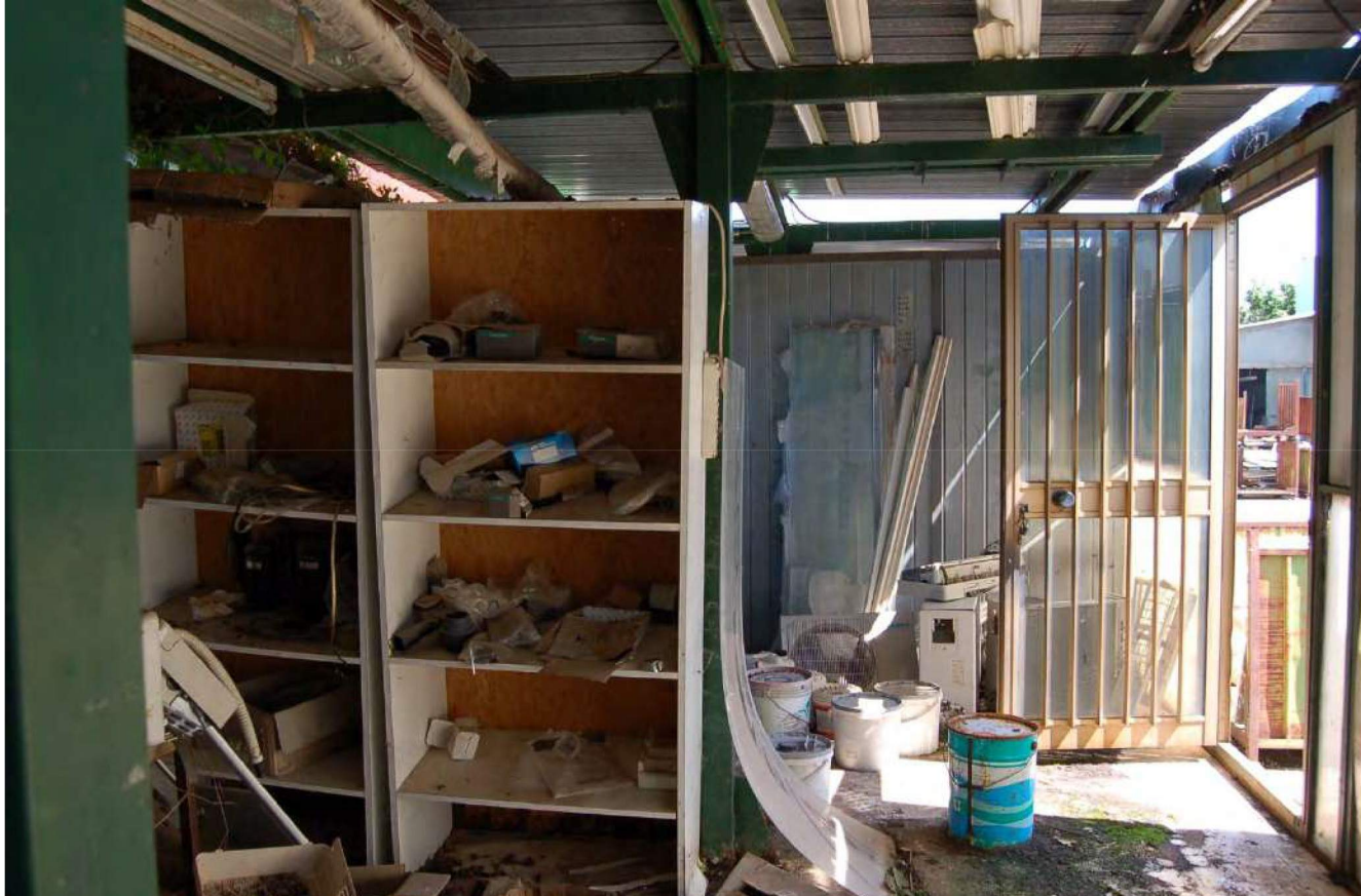
Foto 162 - Vista interna magazzino 3 con accesso dalla porta a battuta
