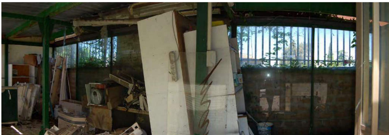
Foto 161 - Vista interna magazzino 3 con accesso dalla porta a battuta
