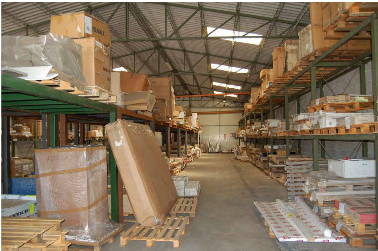
Foto 92 - Campata laterale dx della zona magazzino A3
