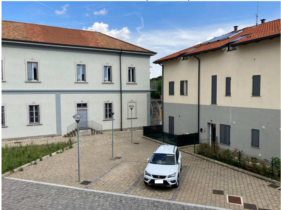
Vista ente comune (cortile interno)
