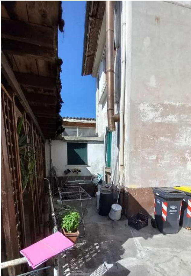
Foto 6 – Vista esterna da area di corte comune
