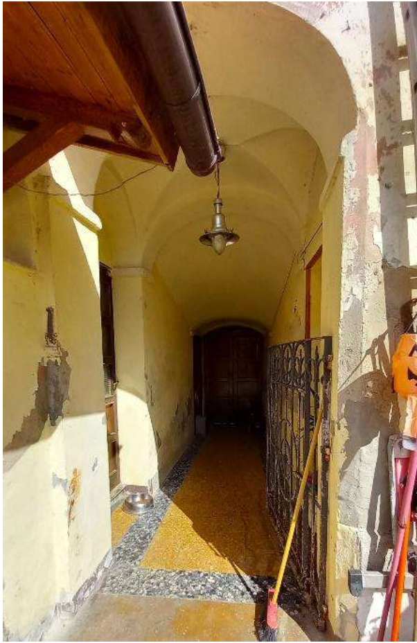
Foto 3 – Vista androne da cortile interno
