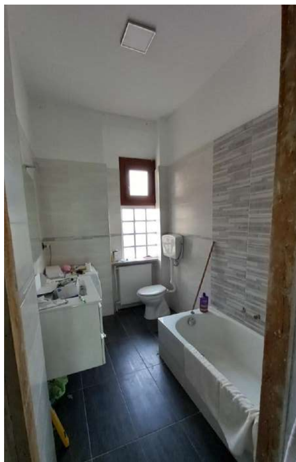
Foto 22 – Vista del bagno
