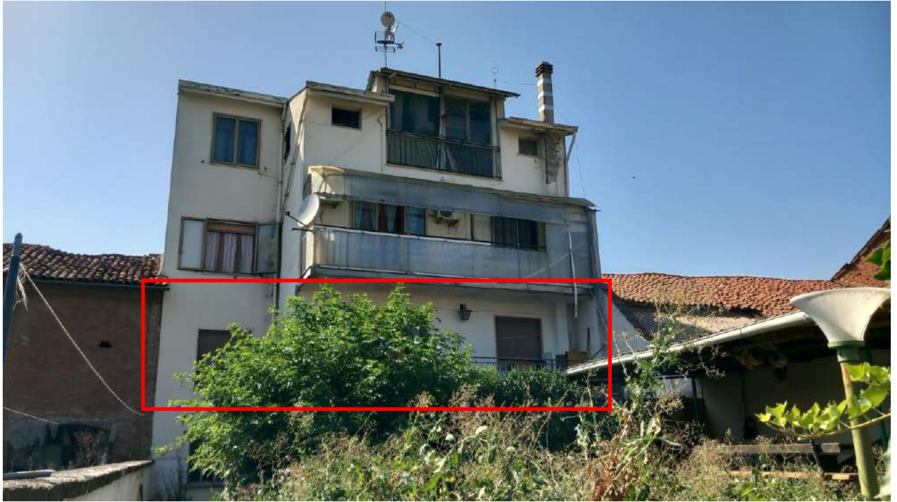
Foto 17 – Vista esterna da cortile interno
