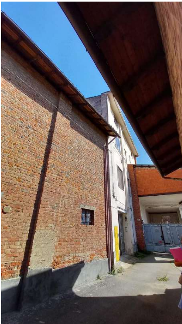
Foto 14 – Vista esterna da Vicolo Collodi
