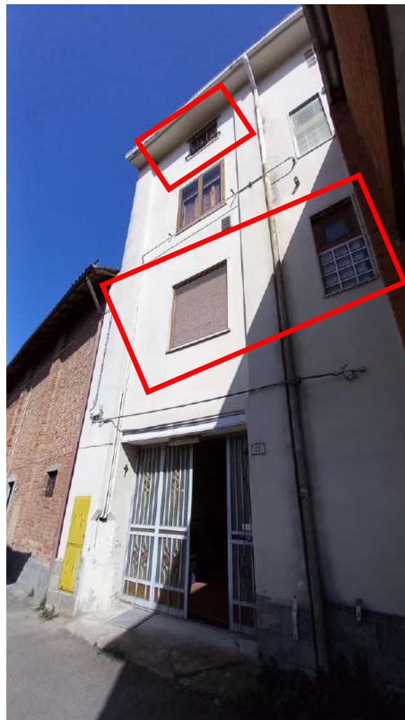
Foto 15 – Vista esterna da Vicolo Collodi
