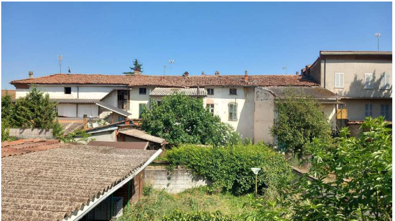
Foto 18 – Vista del fabbricato di Via Verdi da terrazzo alloggio di Vicolo Collodi
