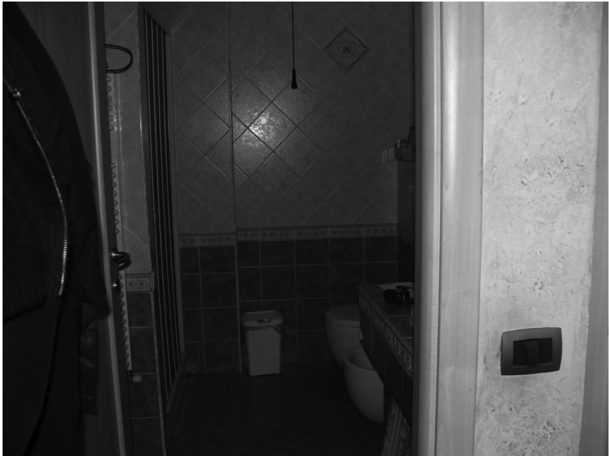
Bagno di servizio al piano terra (diffornità: in progetto è un ripostiglio)
