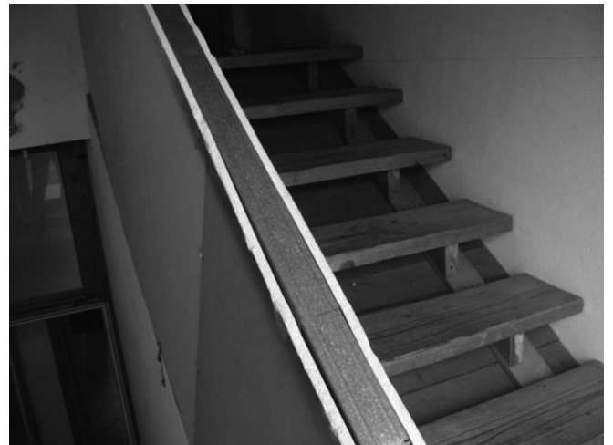
Scala accesso alla mansarda
