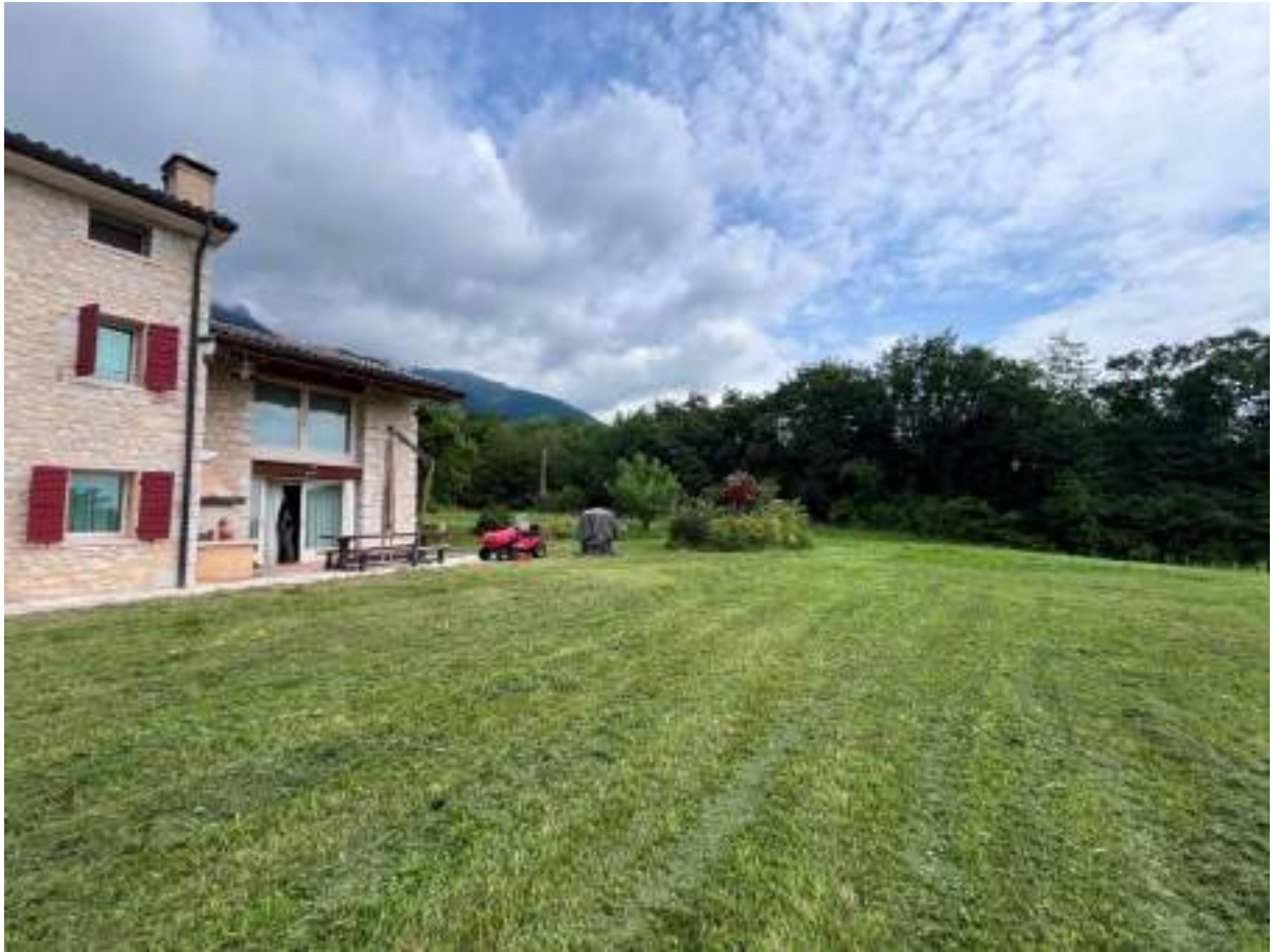
area esterna Sud
