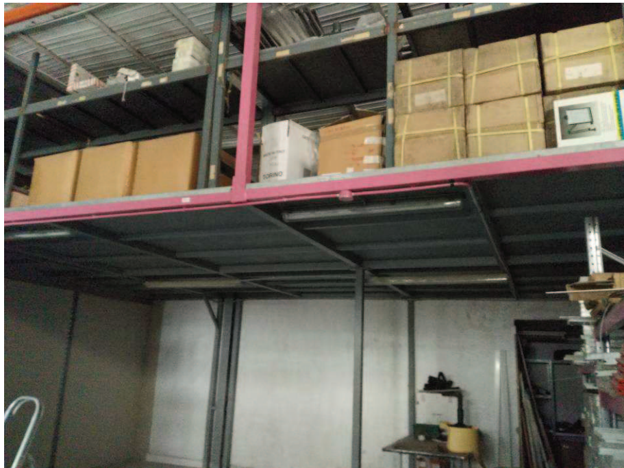
Foto n. 32 – Bene n. 2 - Soppalco
