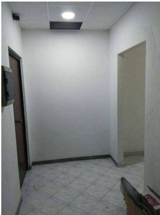
Foto n. 202 – Corridoio comune - sulla sinistra porta di accesso al sub 72 (BCNC non oggetto di pignoramento)
