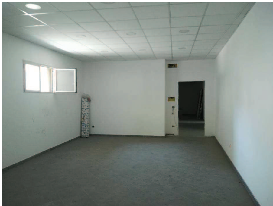
Foto n. 241 – Ingresso al Bene n. 10 - Sub 71 verso l'ingresso
