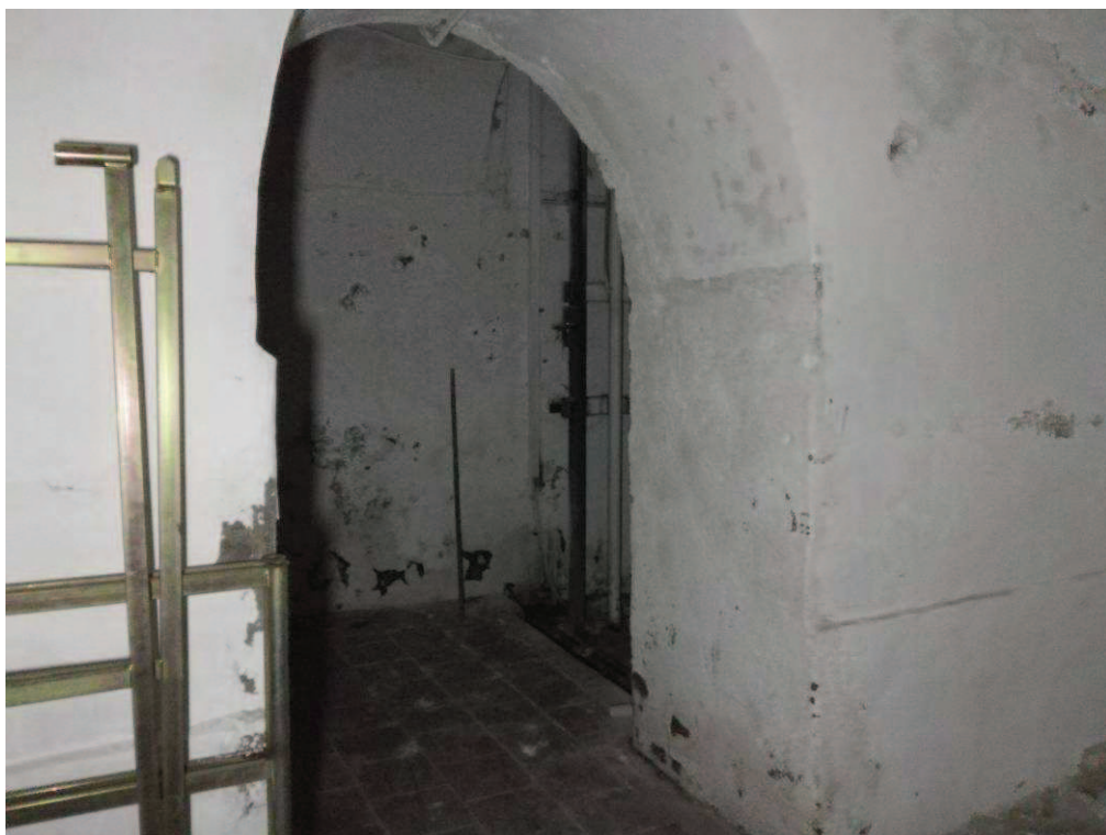
Foto n. 57 – Bene n. 4 - montacarichi di collegamento con il Bene n. 1 sub 59
