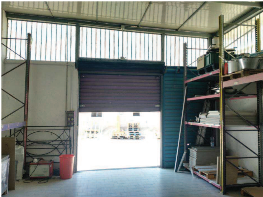
Foto n. 46 – Bene n. 3 verso ingresso
