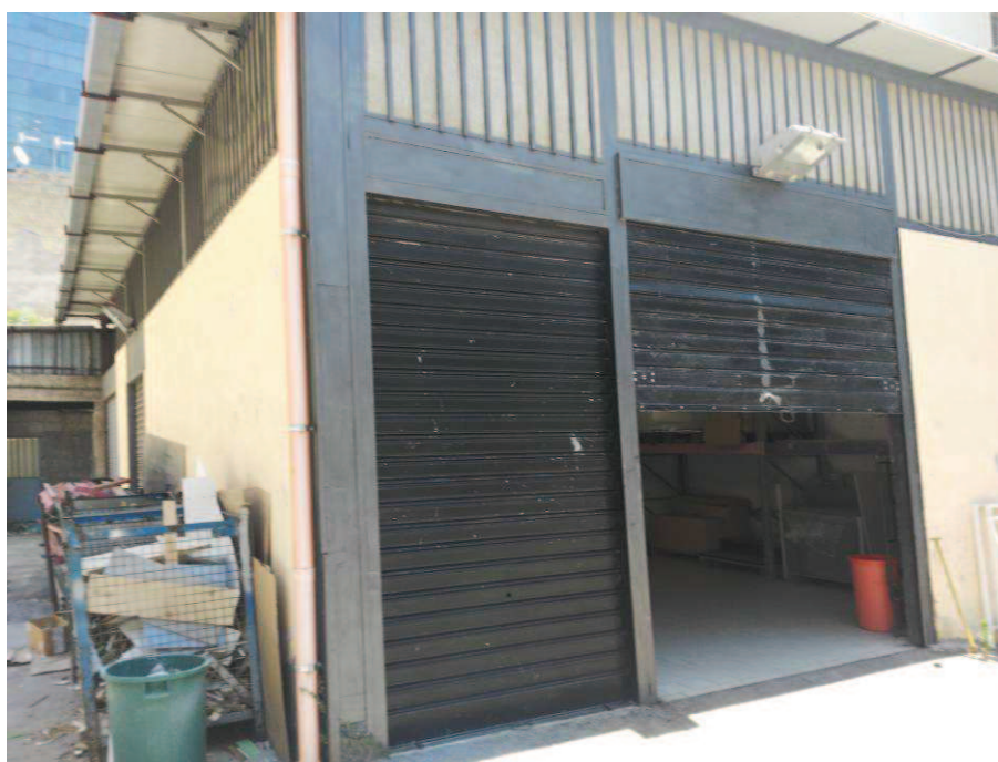
Foto n. 42 – Ingresso all'immobile - Bene n. 3 sub 7
