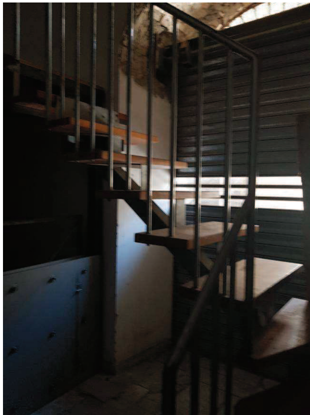
Foto n. 20 – Bene n. 1 - Ambiente n. 11 e 12 - Soppalco
