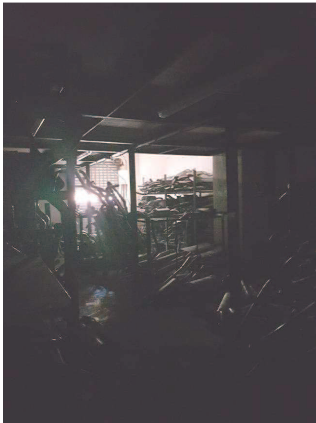
Foto n. 18 – Bene n. 1 - Ambiente n. 11 e 12 - Soppalco
