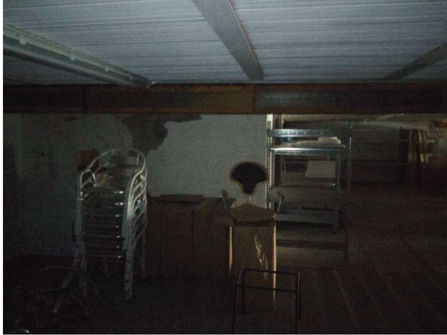
Foto n. 31 – Bene n. 2 - Soppalco
