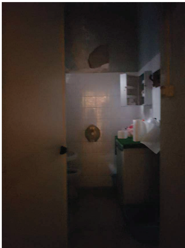
Foto n. 15 – Bene n. 1 - Ambiente n. 9 - Soppalco
