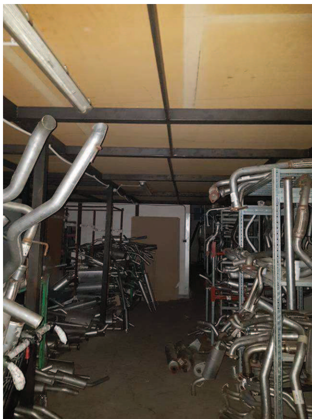
Foto n. 22 – Bene n. 1 - Ambiente n. 11 e 12 - Soppalco
