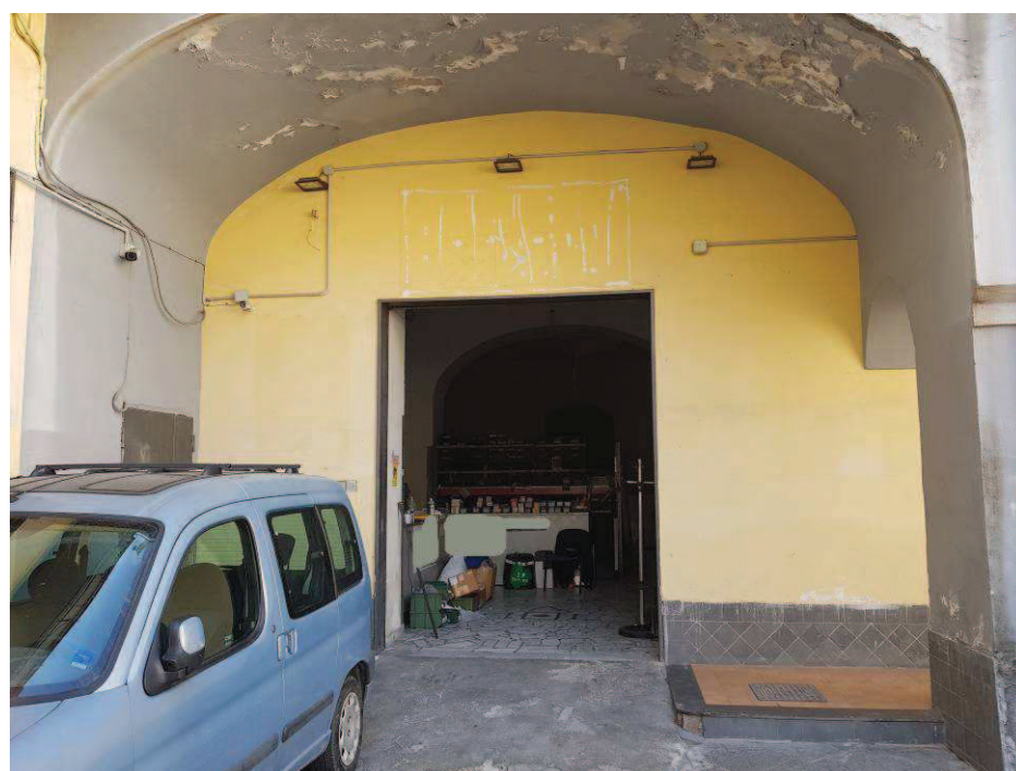
Foto n. 1 – Bene n. 1 - Ingresso
