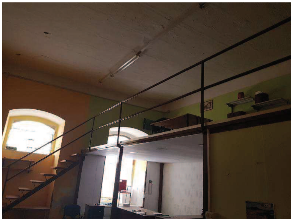
Foto n. 10 – Bene n. 1 - Ambiente n. 9 - Soppalco
