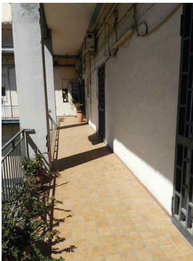
Foto n. 116 – Ingresso dal ballatoio condominiale
