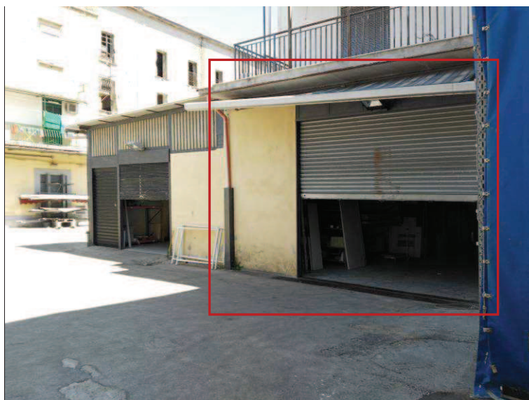
Foto n. 24 – Ingresso all'immobile - Bene n. 2 sub 60
