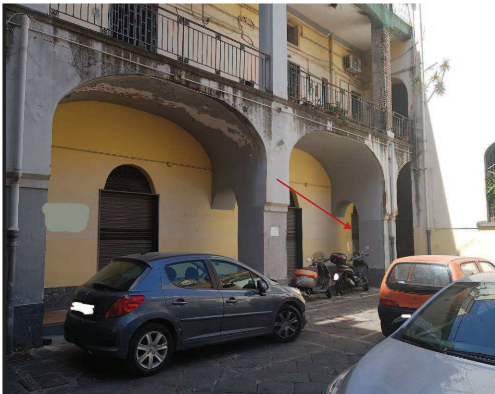
Foto n. 114 – Ingresso dal fabbricato interno cortile
