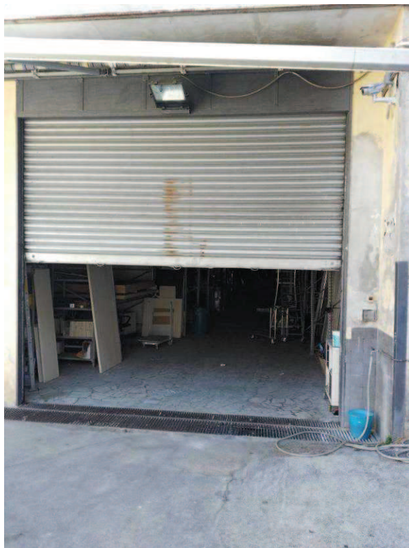
Foto n. 25 – Ingresso all'immobile - Bene n. 2
