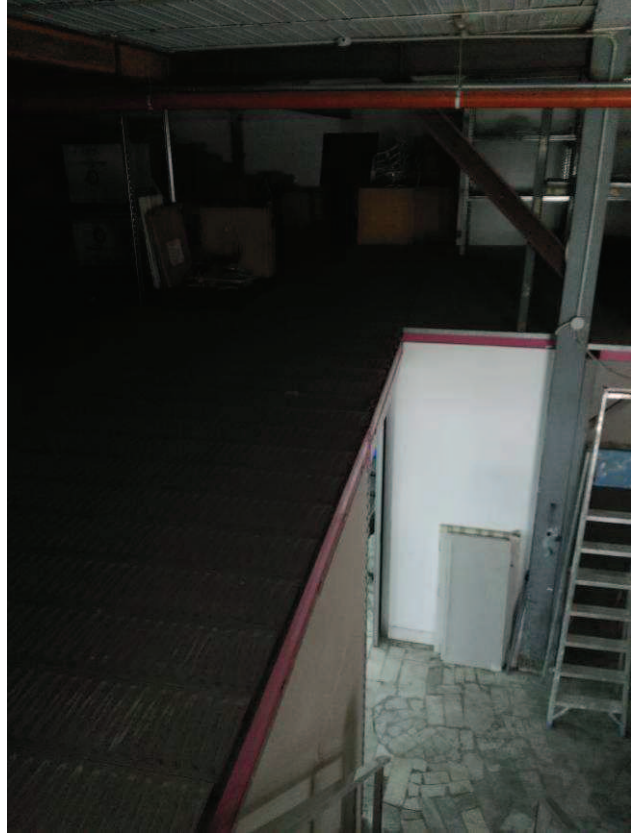
Foto n. 29 – Bene n. 2 - Soppalco
