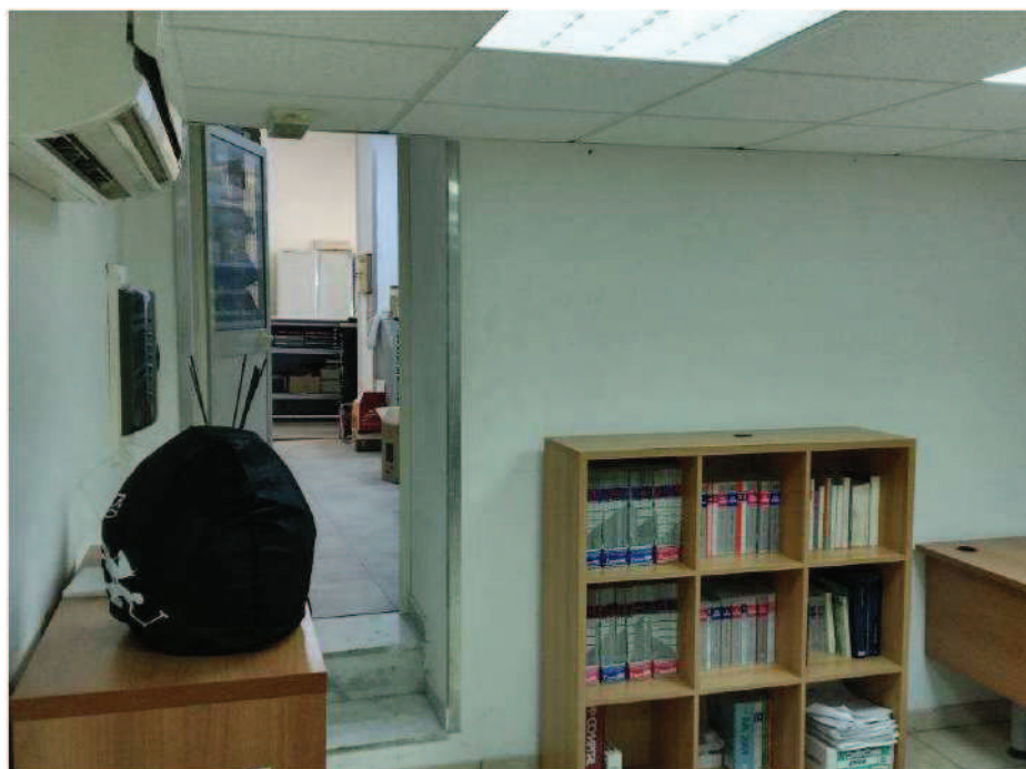
Foto n. 23 – Porta di collegamento con l'immobile di proprietà aliena non oggetto di pignoramento
