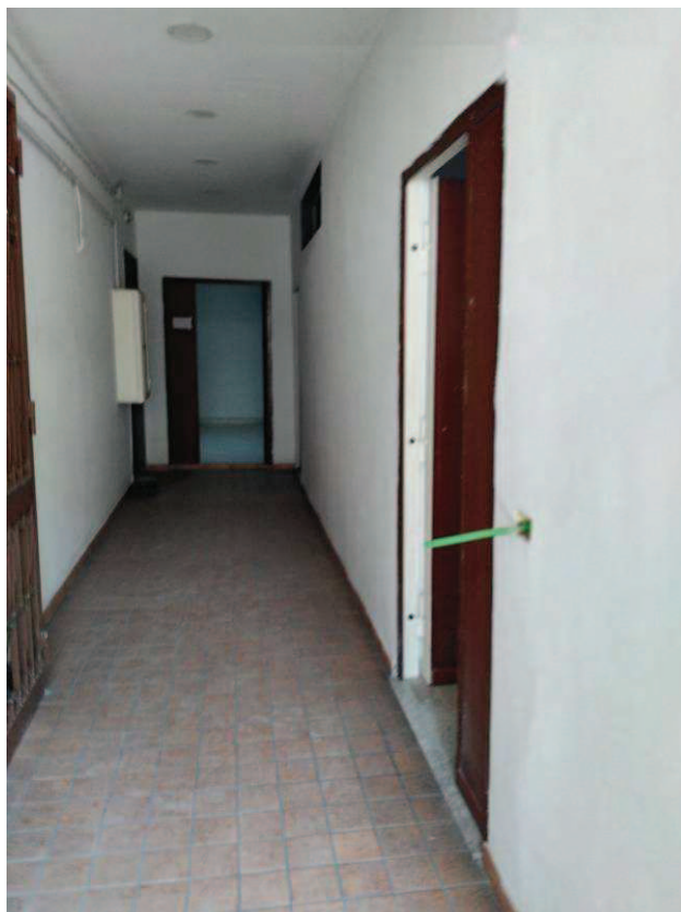
Foto n. 132 – Ingresso dal corridoio comune - Bene n. 2 - sub 62
