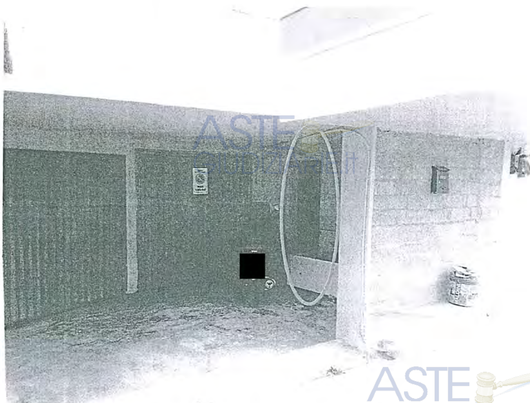
Foto 36 – porta di accesso al sub. 13
