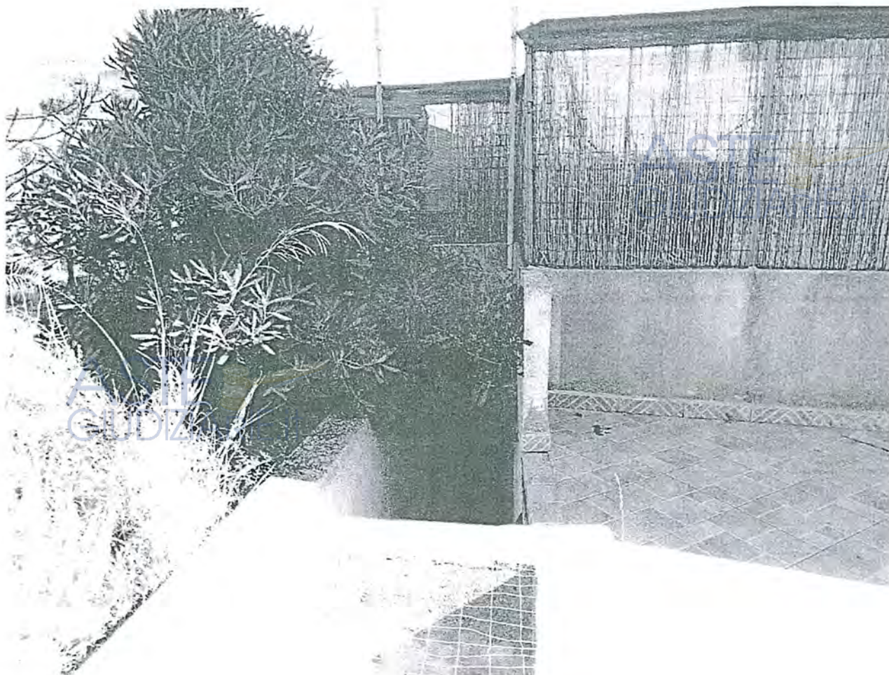
Foto 42 – cortile sub. 13 parte e parte sub. 13 chiuso
