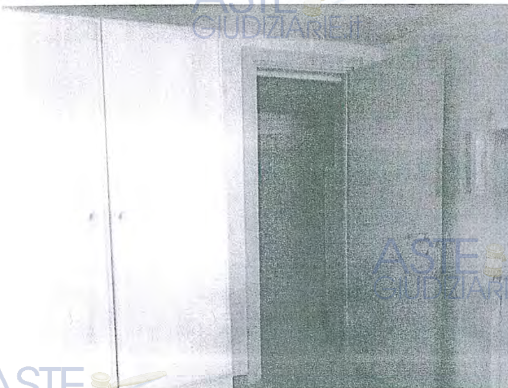
Foto 29 – interno sub. 10 (porta verso il cavedio)
