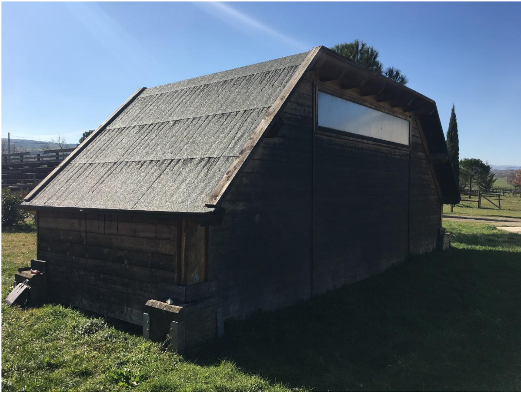
Immobile O Copertura
