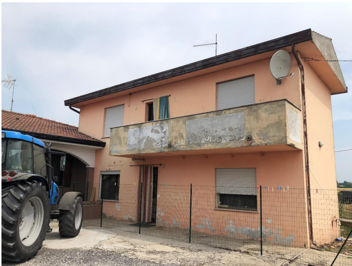
foto n. 3 – facciata sud-ovest del fabbricato
