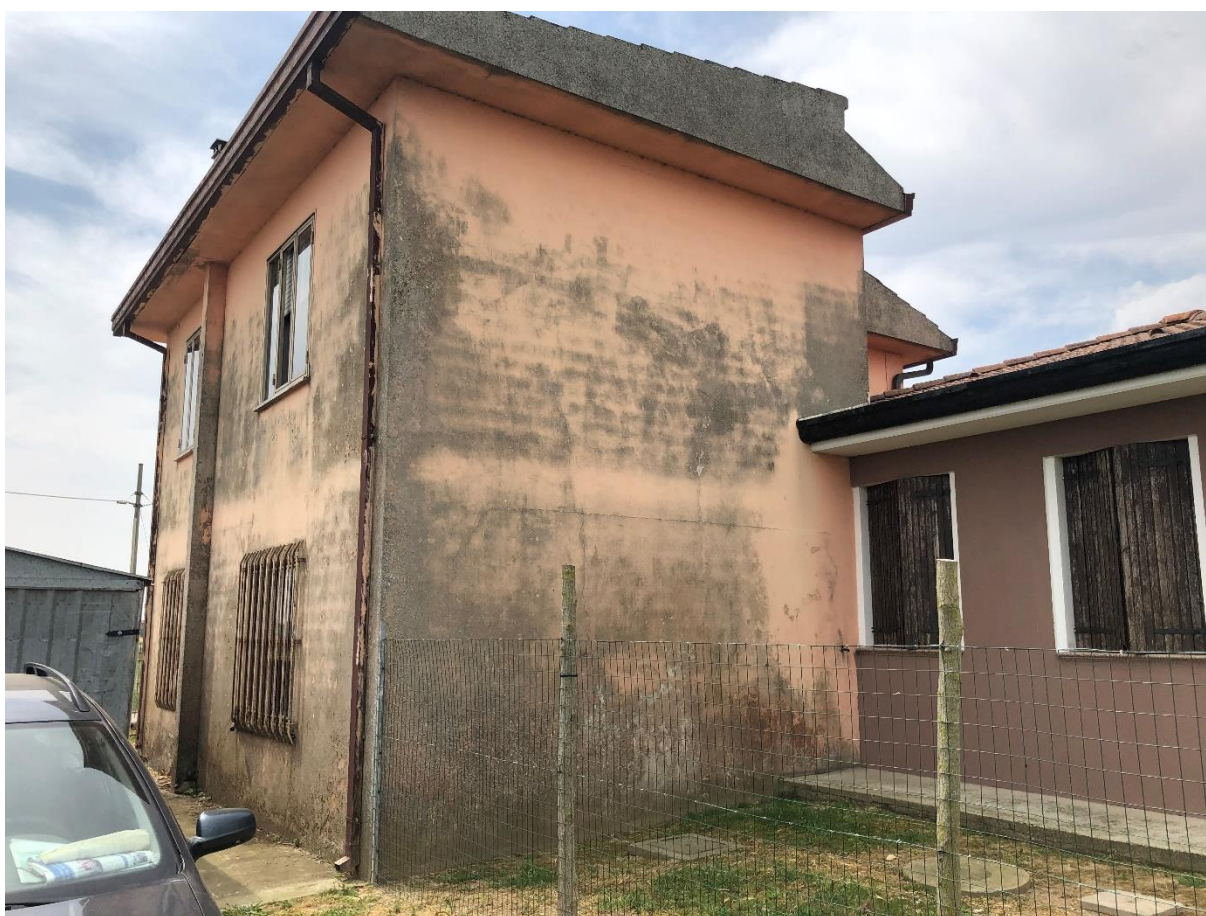
foto n. 4 – facciata nord-ovest fabbricato
