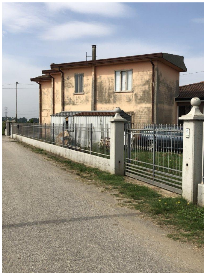
foto n. 1 – facciata nord-est del fabbricato
