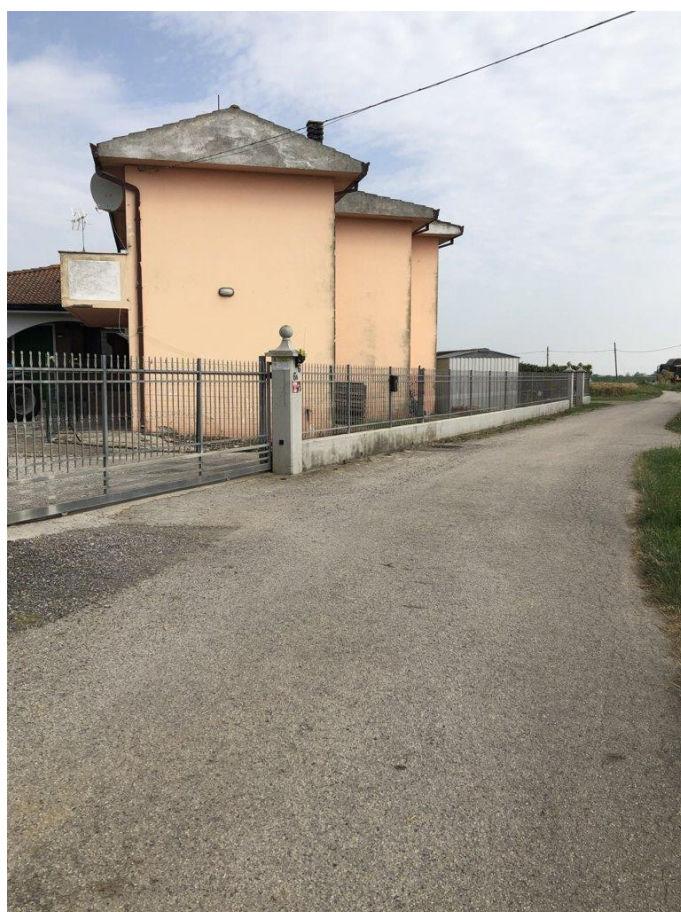
foto n. 2 – angolo sud-ovest del fabbricato
