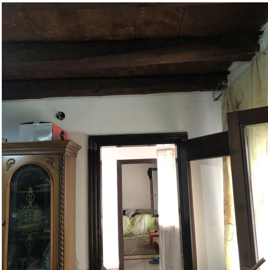
foto n. 10 – cucina a piano terra
