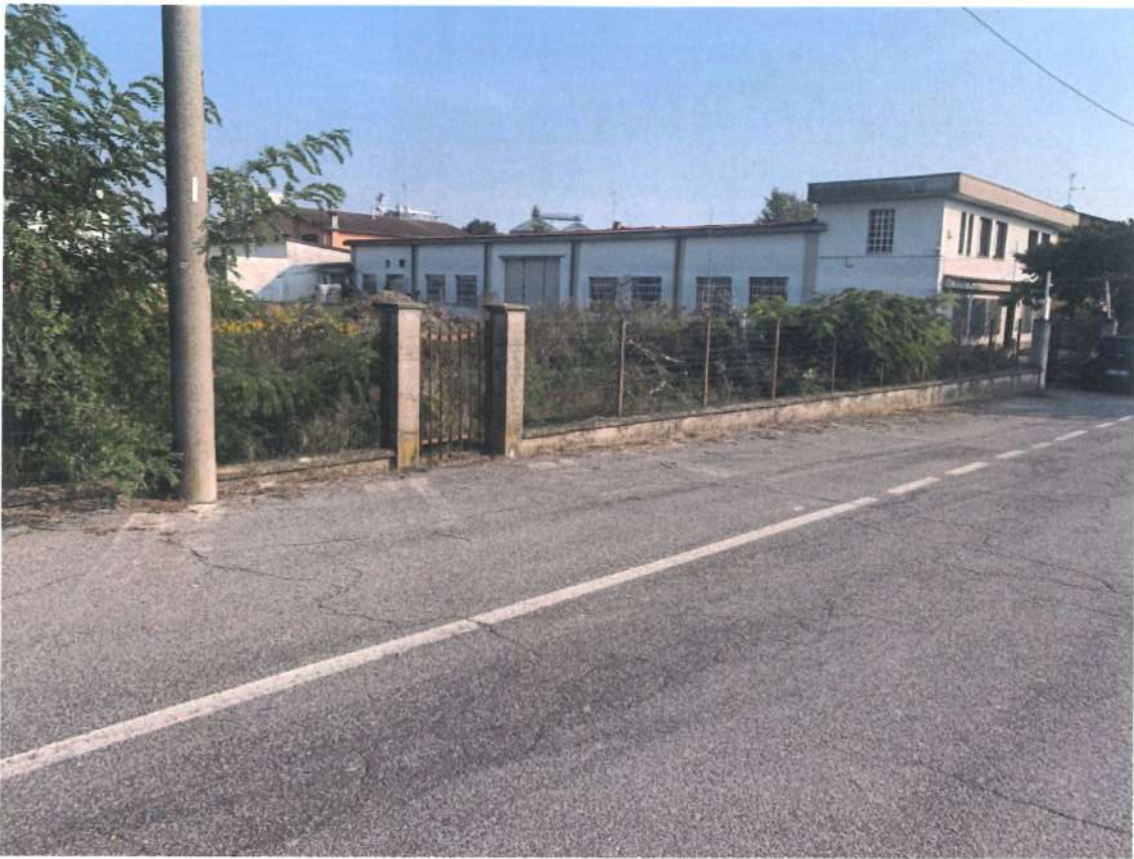
1 – Recinzione su via Marconi
