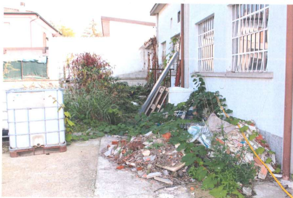
6 – Detriti presenti in adiacenza al prospetto nord del capannone
