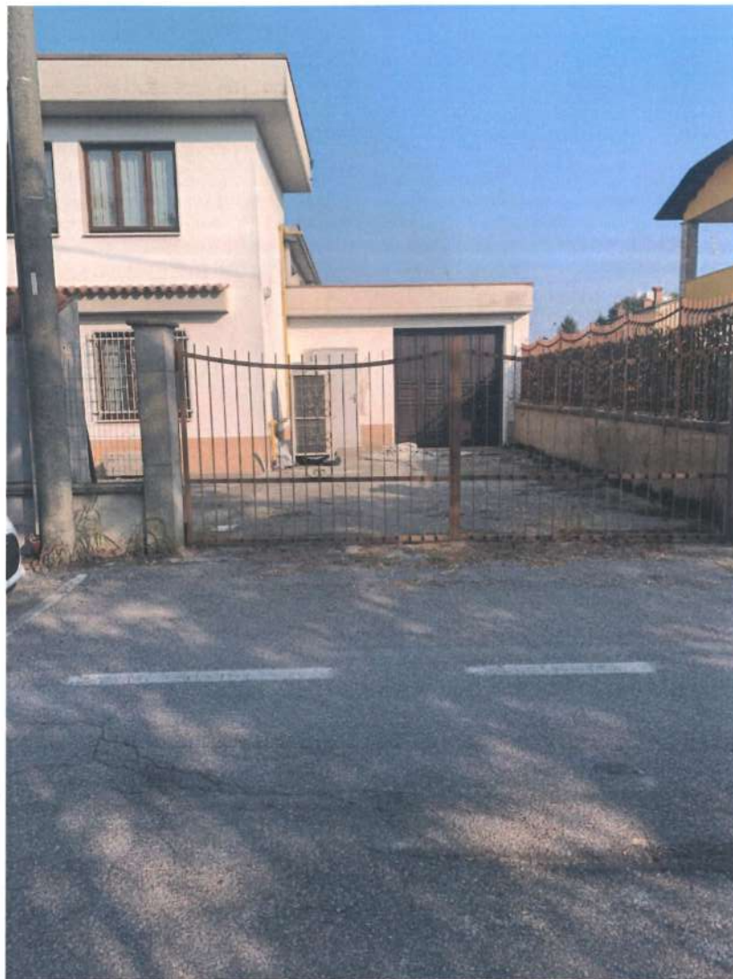
3 – Secondo cancello carraio e porta del fabbricato accessorio lato sud
