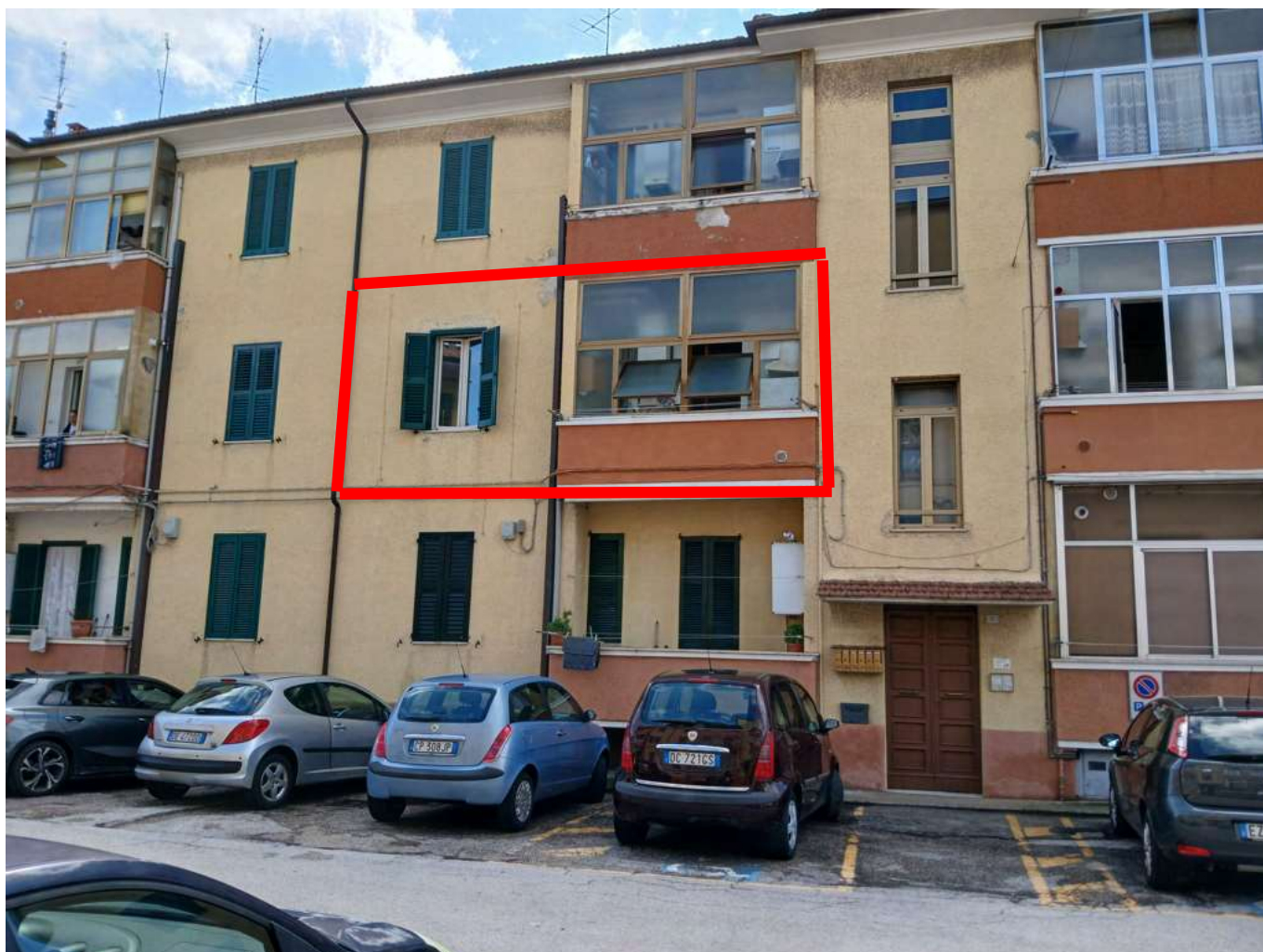
esterno fabbricato (con individuazione dell'unità sub 9)
