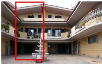
Foto n. 3 – L'edificio visto dal piazzale anteriore
