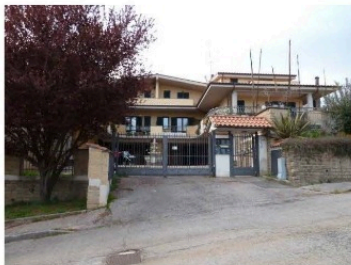
Foto n. 2 – L'edificio di cui è parte l'immobile esecutato
